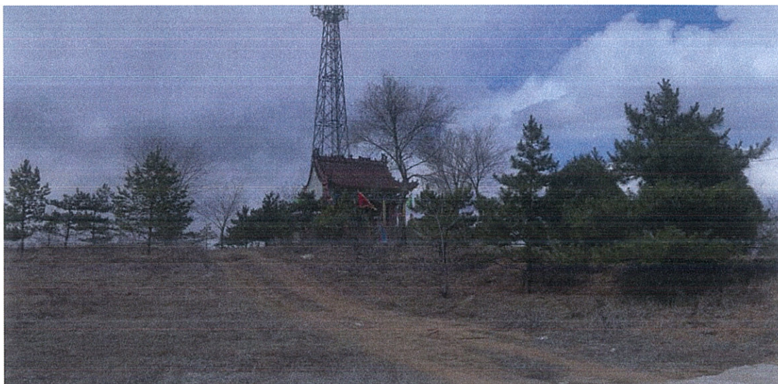
新开沟烽火台现状
