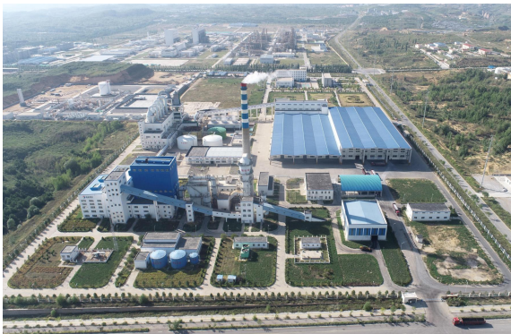
照片 2-2 榆能集团佳县盐化有限公司(镜向 307°)
