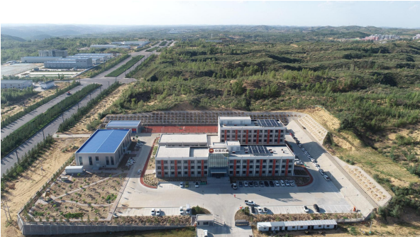
照片 2-10 冀东油田倒班公寓 (镜向 312°)
