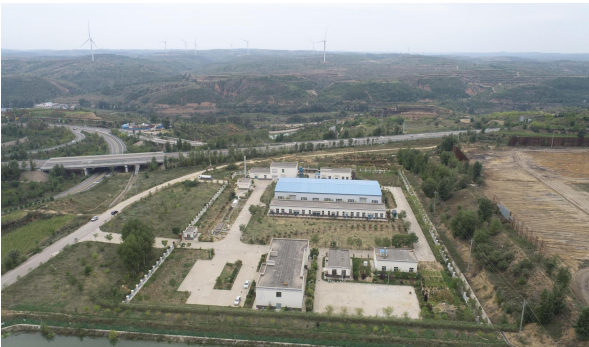
照片 2-13 污水处理厂(镜向 327°)
