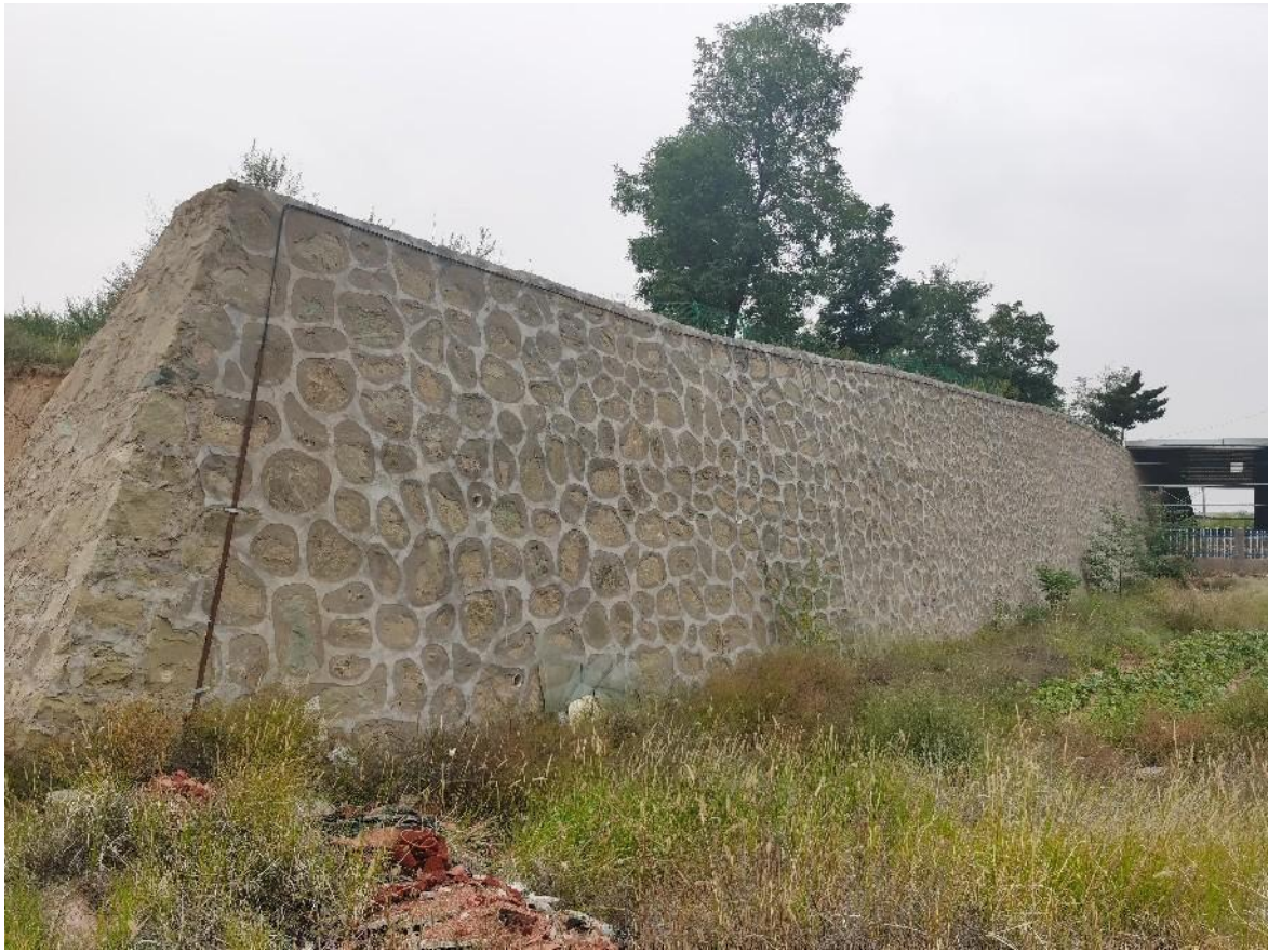
图 2-27 社区工厂西侧护坡挡墙（镜向 342°）
