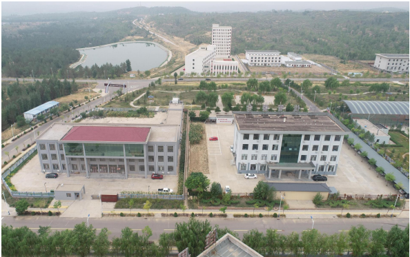
照片 2-1 园区管委会(镜向 212°)
