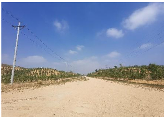
照片 3-11 道路修建（镜向 125°）
