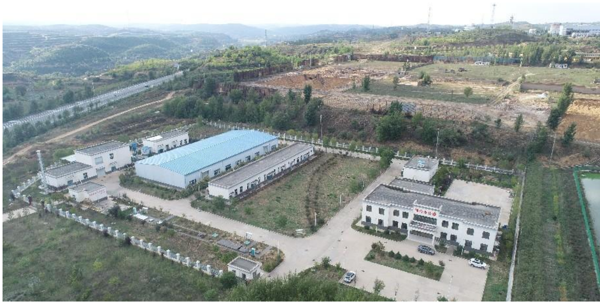
照片 5-25 污水处理厂（镜向 355°）
