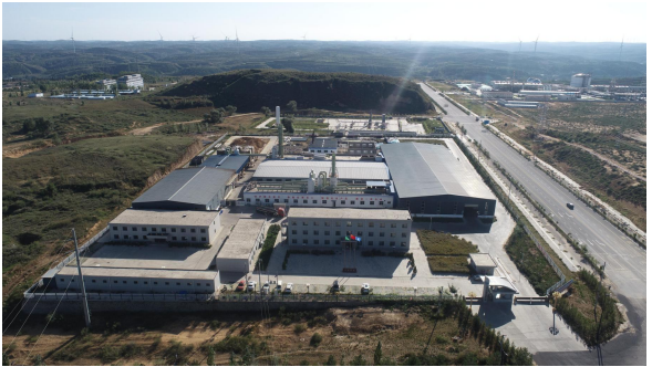
照片 2-11 玉泉材料科技有限公司(镜向 224°)
