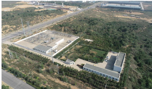
照片 2-14 110V 变电站 (镜向 33°)
