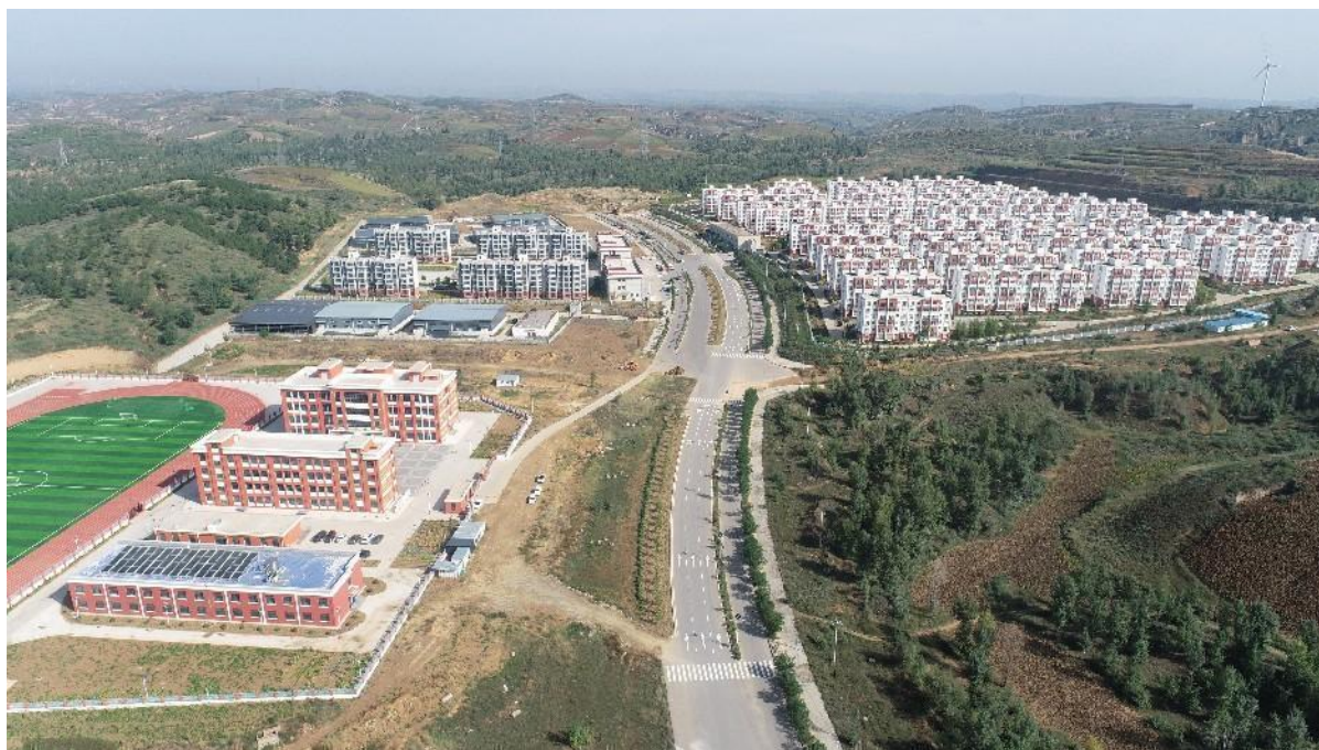
照片 3-3 园区西北部地形地貌（镜向355°）
