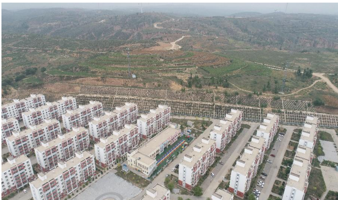
图 5-4 移民小区东侧格构护坡（镜向 74°）
