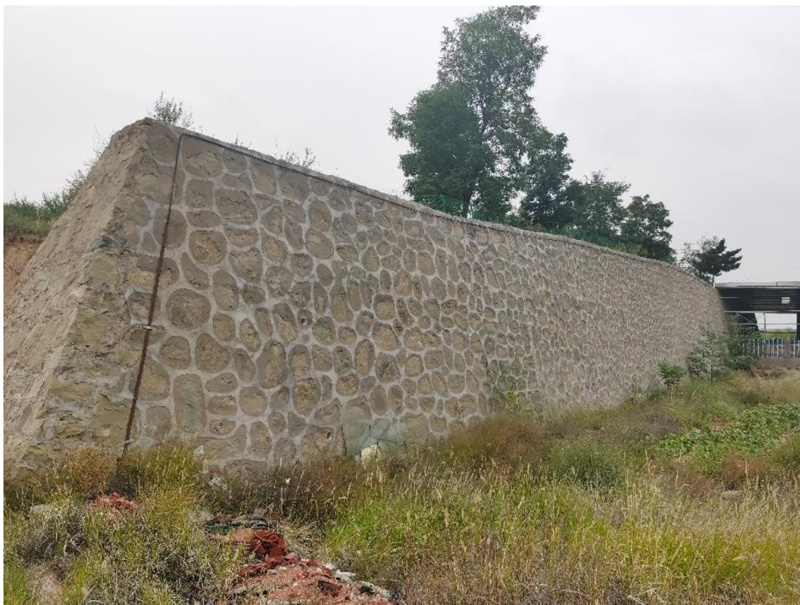
图 5-3 社区工厂西侧护坡挡墙（镜向 342°）
