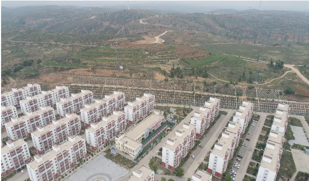
图 2-28 移民小区东侧格构护坡（镜向 74°）
