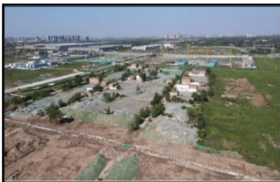
园区平缓原始地貌
