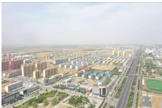
照片 3-19 园区建设（镜向 50°）
