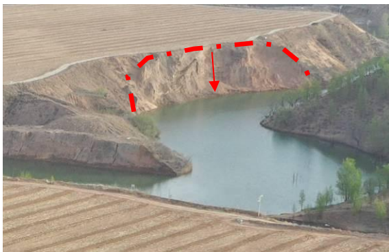
照片 3-25 塘岸坡塌岸（镜向 170°）
