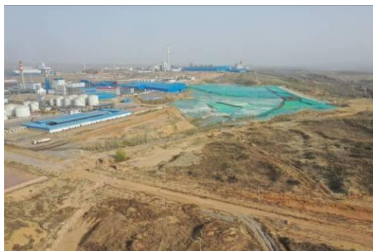
照片 3-20 修排土场（镜向 150°）
