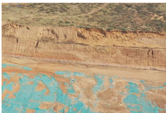
照片 3-21 挖方边坡（镜向 5°）
