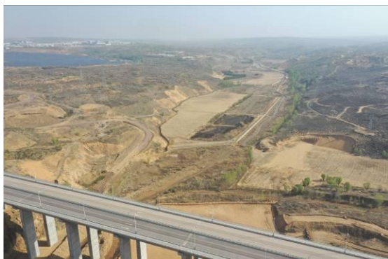
照片 3-7 青杨树沟主沟道（镜向 40°）
