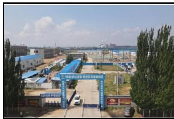
园区在建区域
