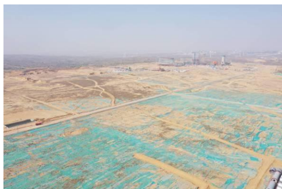
照片 5-9 新材料产业集中区黄土梁顶部人工平整
