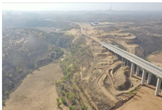
照片 5-10 新材料产业集中区黄土梁前缘斜坡
