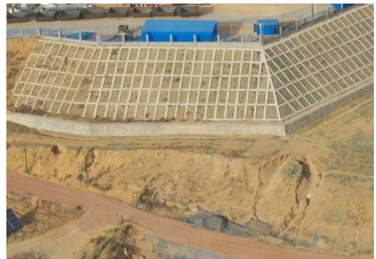
照片 3-22 边坡防护措施（镜向 15°）
