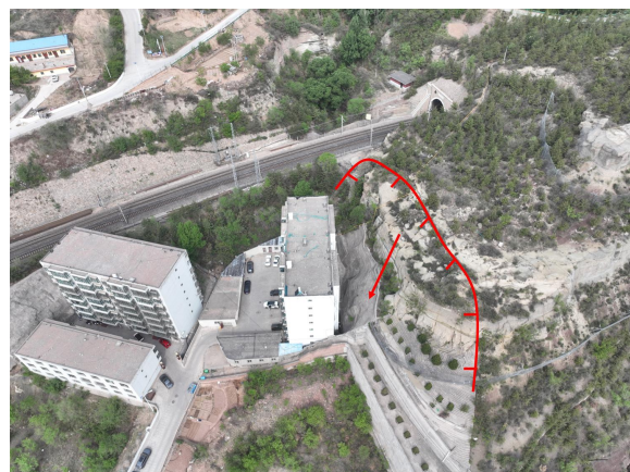
照片 4.2-76 BY14 崩塌隐患（镜向 290°）
