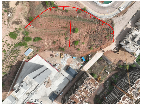
照片 4.2-60 BY07 崩塌隐患（镜向 350°）
