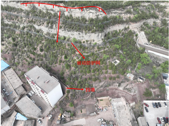
照片 4.2-71 BY12 崩塌隐患（镜向 225°）
