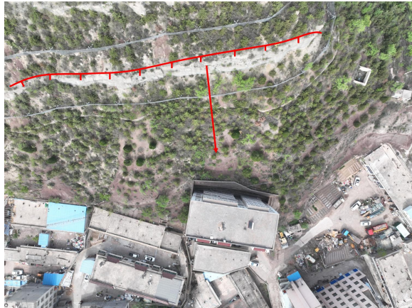
照片 4.2-72 BY12 崩塌隐患（镜向 300°）
