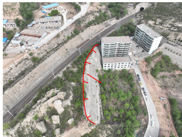
照片 4.2-78 BY15 崩塌隐患（镜向 310°）
