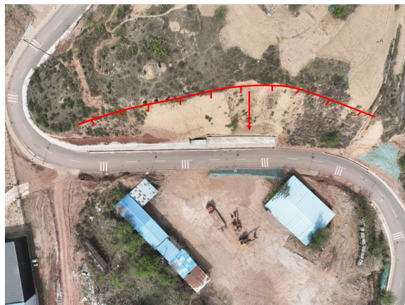
照片 4.2-22 B08 崩塌（镜向 310°）
