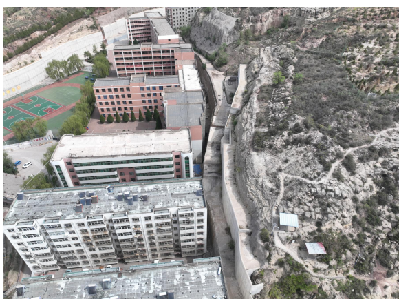
照片 3.8-7 府谷三中边坡（镜像 50°）
