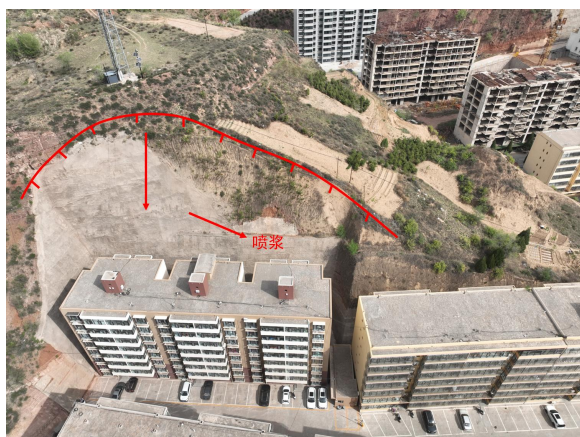
照片 4.2-55 BY05 崩塌隐患（镜向 325°）
