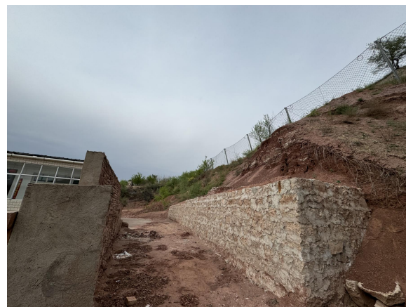
照片 4.2-46 B14 崩塌治理工程 (镜向 10°)
