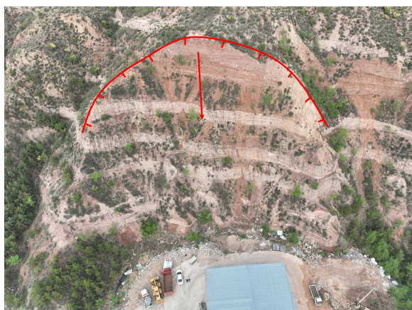
照片 4.2-63 BY09 崩塌隐患（镜向 260°）
