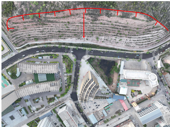
照片 4.2-7 B03 崩塌（镜向 325°）
