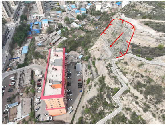
照片 4.2-38 B12 崩塌（镜向 170°）
