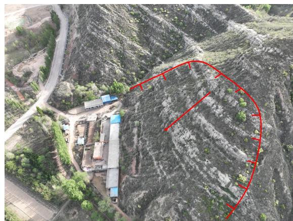
照片 4.2-6 B02 崩塌（镜向 210°）
