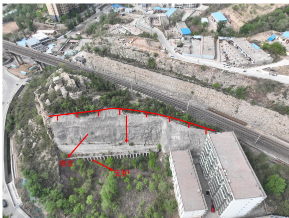
照片 4.2-77 BY15 崩塌隐患（镜向 220°）
