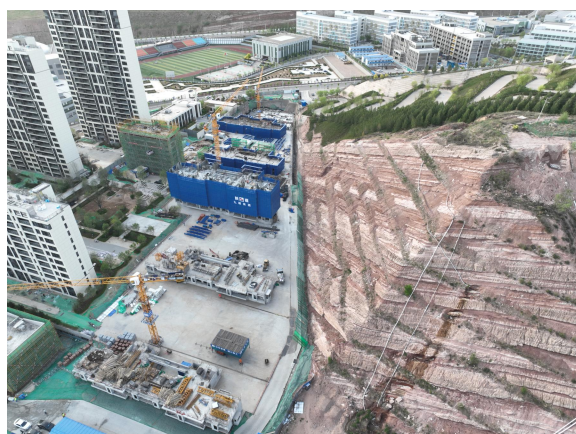
照片 3.8-8 住宅楼建设（镜像 10°）
