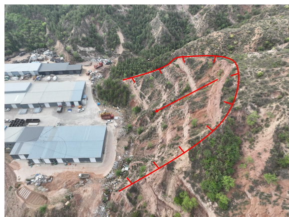
照片 4.2-64 BY09 崩塌隐患（镜向 190°）
