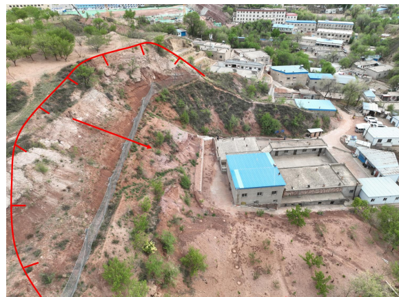
照片 4.2-44 B14 崩塌（镜向 170°）
