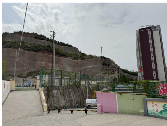
照片 4.2-35 B11 崩塌治理工程（镜向 225°）
