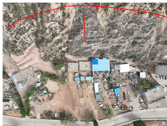
照片 4.2-14 B06 崩塌（镜向 315°）
