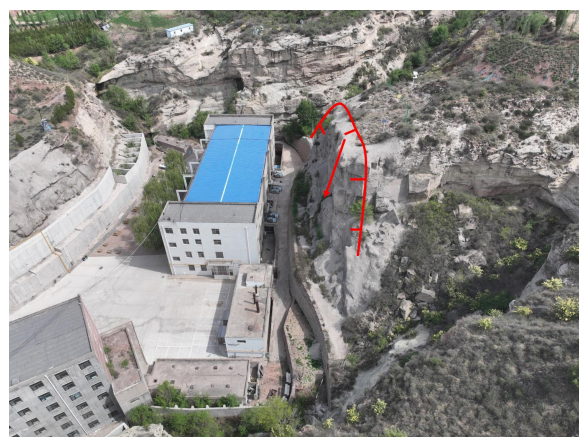
照片 4.2-42 B13 崩塌（镜向 20°）
