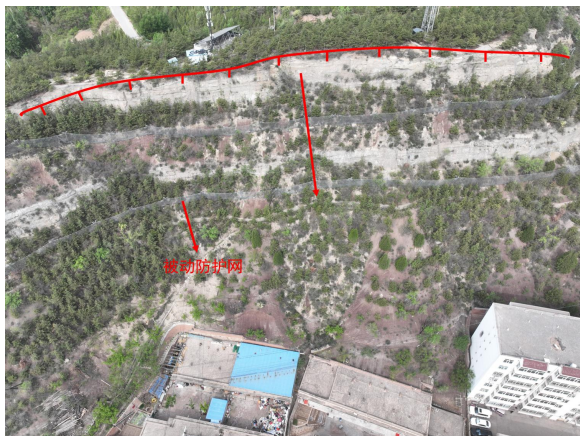
照片 4.2-73 BY13 崩塌隐患（镜向 320°）
