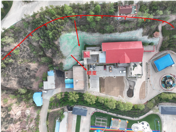
照片 4.2-65 BY10 崩塌隐患 (镜向 60°)
