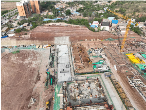
照片 2.2-1 府谷县第六小学、第十三幼儿园场平项目施工
