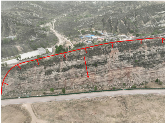
照片 4.2-1 B01 崩塌（镜向 305°）
