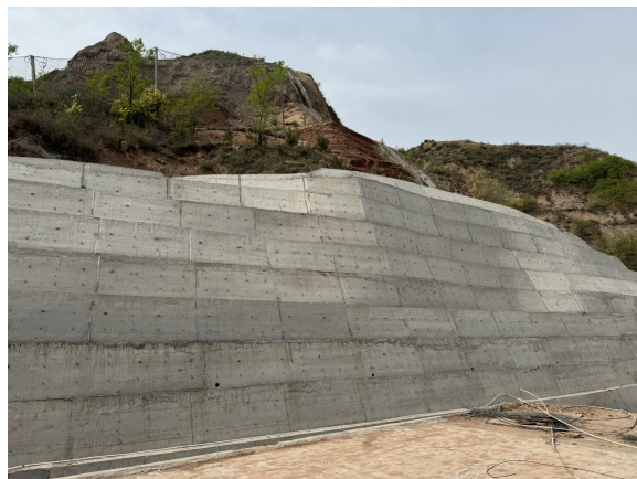
照片 4.2-20 B07 崩塌治理工程（镜向 200°）
