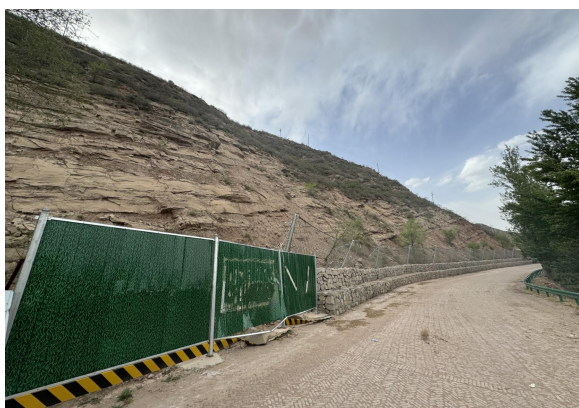
照片 4.2-3 B01 崩塌东侧治理工程（镜向 20°）
