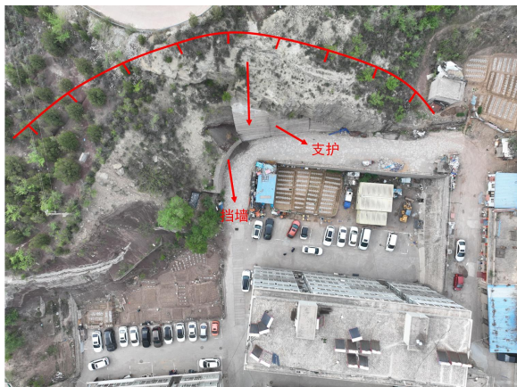
照片 4.2-29 B10 崩塌（镜向 170°）
