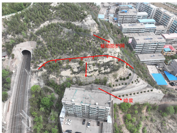
照片 4.2-75 BY14 崩塌隐患（镜向 30°）
