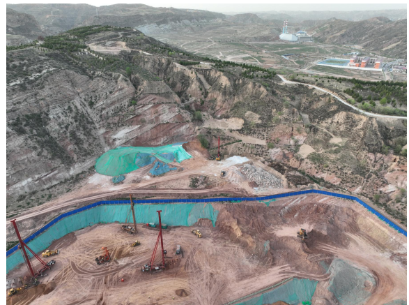
照片 2.2-4 府谷六中项目施工现场（镜像 60°）
