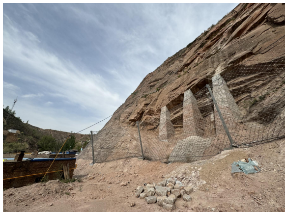
照片 4.2-15 B06 崩塌治理工程（镜向 20°）
