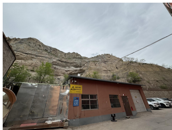
照片 4.2-40 B12 崩塌治理工程（镜向 180°）
