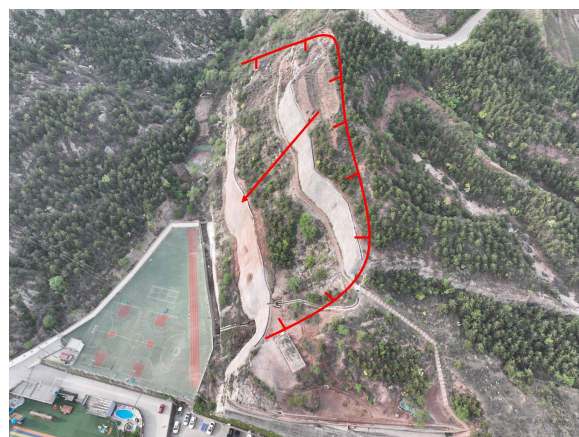
照片 4.2-34 B11 崩塌（镜向 170°）
