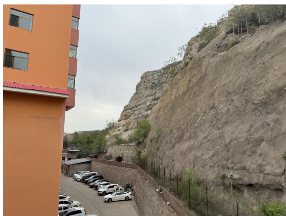
照片 4.2-39 B12 崩塌治理工程（镜向 225°）
