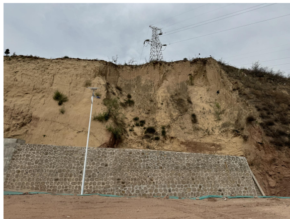
照片 4.2-24 B08 崩塌治理工程（镜向 200°）
