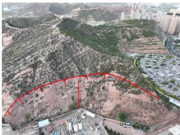
照片 4.2-51 BY03 崩塌隐患 (镜向 45°)
