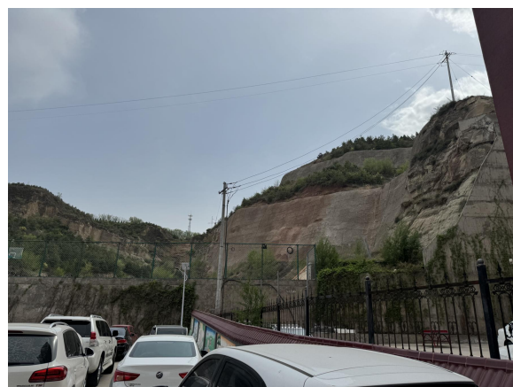
照片 4.2-36 B11 崩塌治理工程（镜向 180°）
