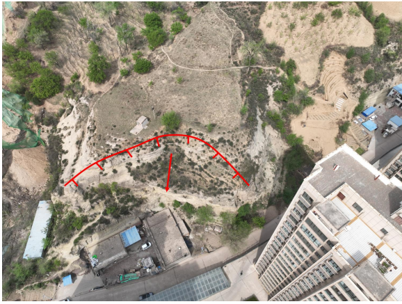
照片 4.2-87 BY20 崩塌隐患（镜向 310°）
