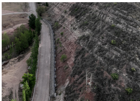
照片 4.2-4 B01 崩塌东侧治理工程（镜向 200°）
