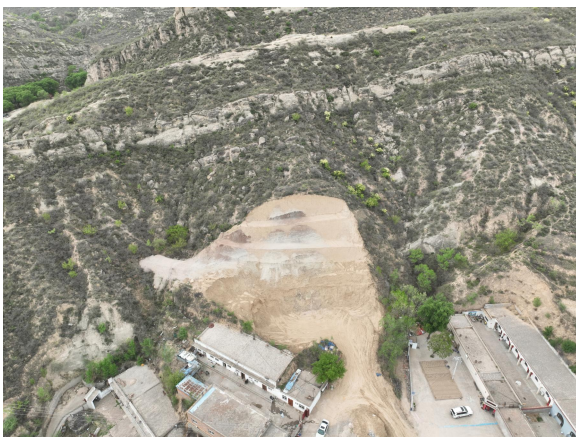
照片 2.2-5 房屋修建开挖坡脚（镜像 330°）
