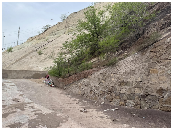
照片 4.2-28 B09 崩塌治理工程（镜向 300°）
