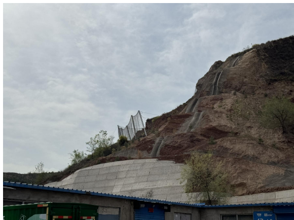
照片 4.2-19 B07 崩塌治理工程（镜向 20°）
