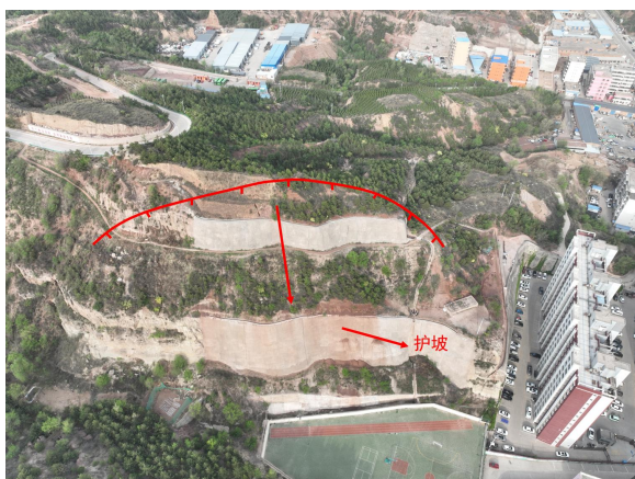
照片 4.2-33 B11 崩塌（镜向 225°）
