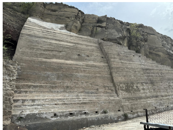
照片 4.2-32 B10 崩塌治理工程（镜向 300°）
