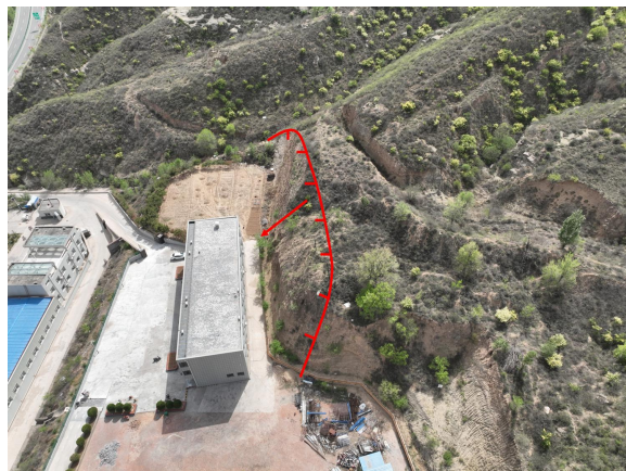
照片 4.2-48 BY01 崩塌隐患（镜向 210°）
