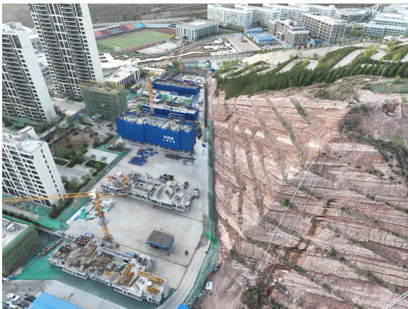
照片 2.2-3 阴塔山公园西侧新建小区项目施工现场（镜像
