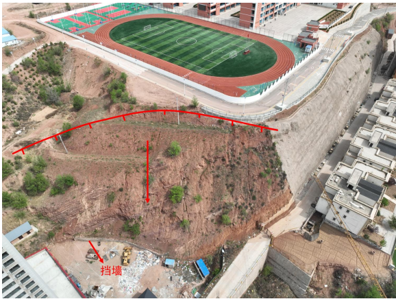
照片 4.2-59 BY07 崩塌隐患（镜向 10°）
