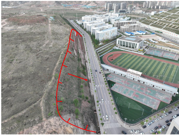
照片 4.2-50 BY02 崩塌隐患（镜向 60° ）
