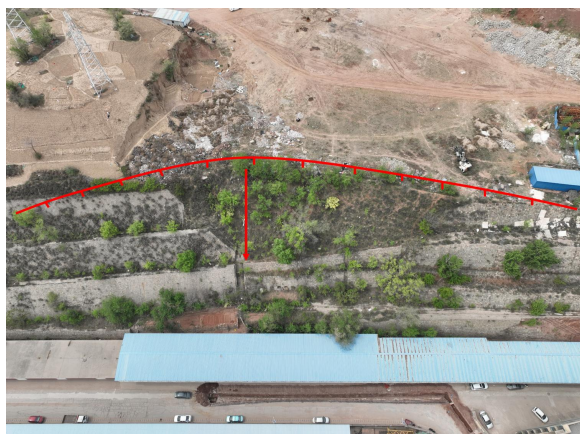
照片 4.2-61 BY08 崩塌隐患（镜向 220°）
