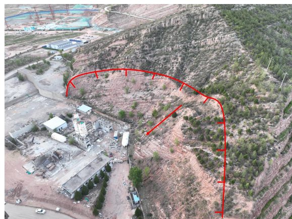
照片 4.2-52 BY03 崩塌隐患 (镜向 310°)
