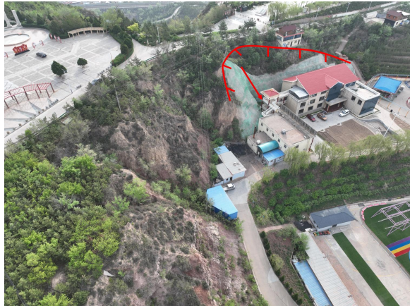
照片 4.2-66 BY10 崩塌隐患 (镜向 75°)
