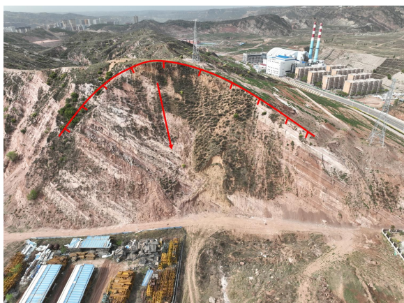
照片 4.2-53 BY04 崩塌隐患（镜向 225°）
