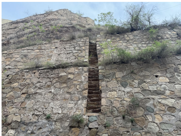
照片 4.2-27 B09 崩塌治理工程（镜向 340°）
