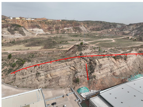
照片 4.2-11 B05 崩塌（镜向 310°）
