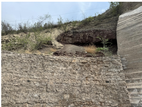
照片 4.2-31 B10 崩塌治理工程（镜向 340°）
