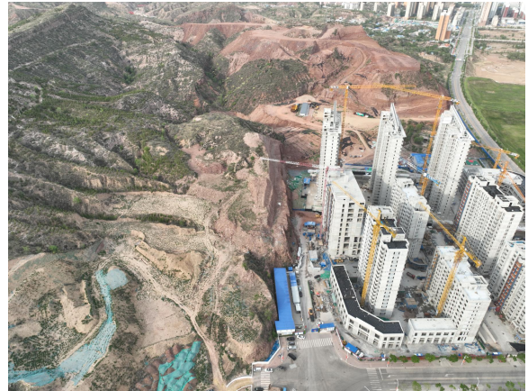
照片 2.2-2 府兴街北新建小区项目施工现场（镜像 80°）
