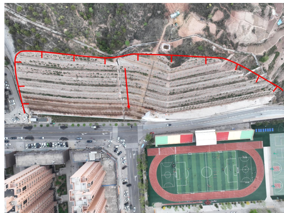
照片 4.2-10 B04 崩塌 (镜向 225°)
