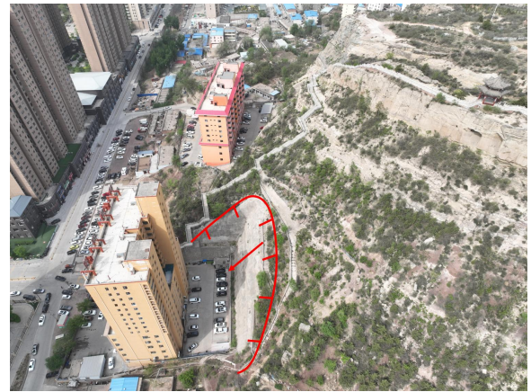
照片 4.2-82 BY17 崩塌隐患（镜向 240°）
