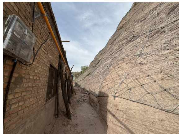
照片 4.2-16 B06 崩塌治理工程（镜向 200°）
