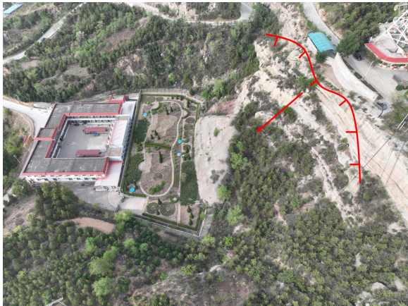
照片 4.2-70 BY11 崩塌隐患（镜向 225°）
