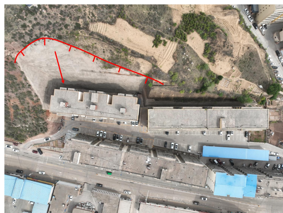
照片 4.2-56 BY05 崩塌隐患（镜向 350°）
