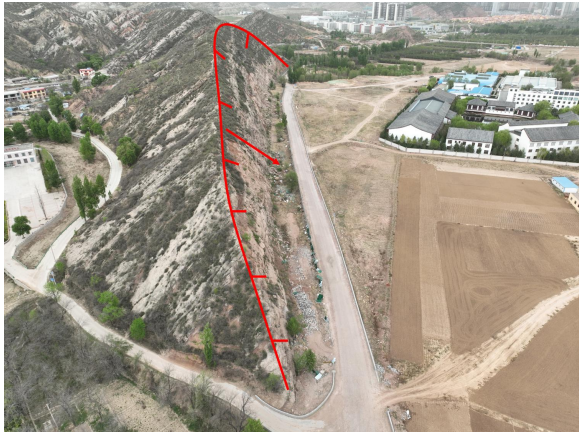
照片 4.2-2 B01 崩塌（镜向 30°）
