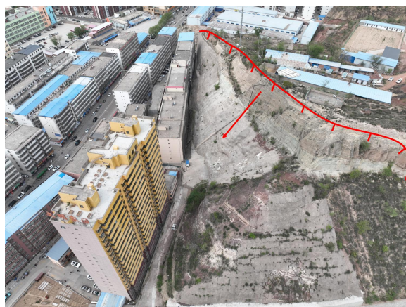
照片 4.2-26 B09 崩塌（镜向 260°）
