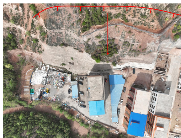
照片 4.2-18 B07 崩塌（镜向 260°）
