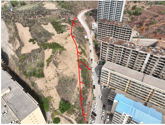
照片 4.2-58 BY06 崩塌隐患（崩塌 315° ）
