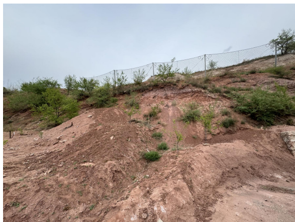
照片 4.2-45 B14 崩塌治理工程 (镜向 90°)
