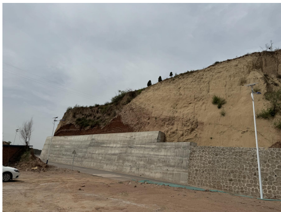
照片 4.2-23 B08 崩塌治理工程（镜向 240°）
