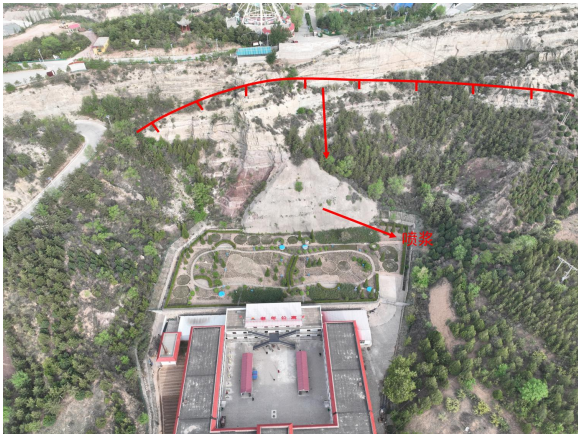
照片 4.2-69 BY11 崩塌隐患（镜向 300°）
