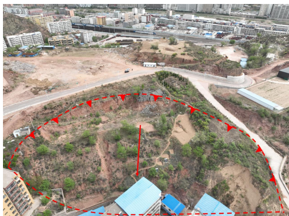
照片 4.2-95 HY02 滑坡隐患（镜向 30°）
