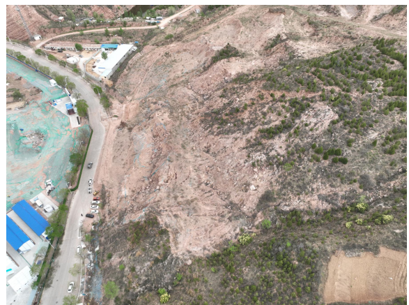
照片 2.2-6 新建小区山体开挖（镜像 30°）
