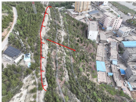
照片 4.2-74 BY13 崩塌隐患（镜向 40°）
