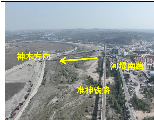
照片 3-23 项目区南侧道路分布
