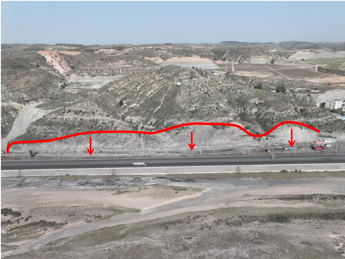
图 4-5 B01 崩塌全貌（镜像 100°）
