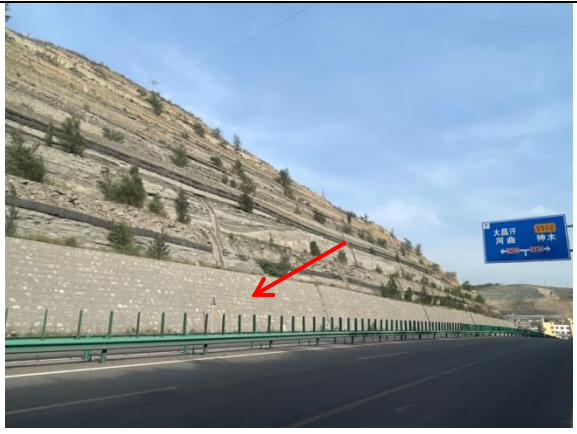
4-11 坡脚处分级放坡+已建挡墙（镜像 135°）
