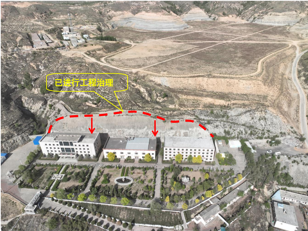
图 4-8 B02 崩塌全貌（镜像 100°）
