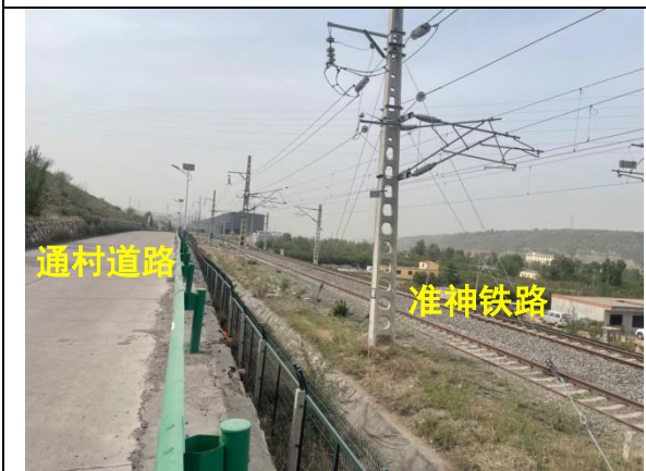
照片 3-25 项目区北侧道路分布（二）
