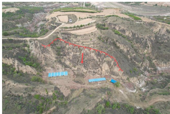
照片 4.1-2 崩塌隐患 BY01（镜向 315°）
