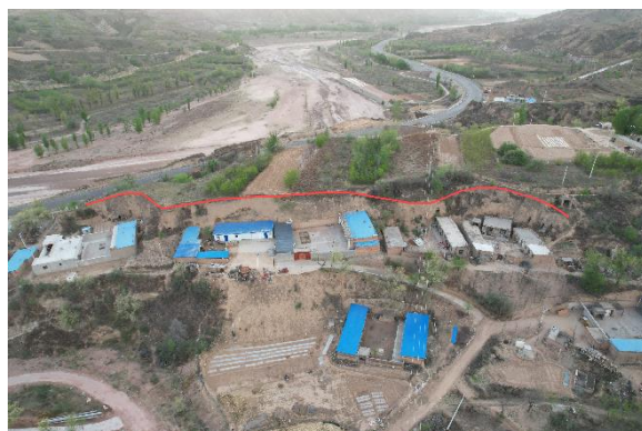
照片 4.1-12 不稳定斜坡 BW04（镜向 315°）
