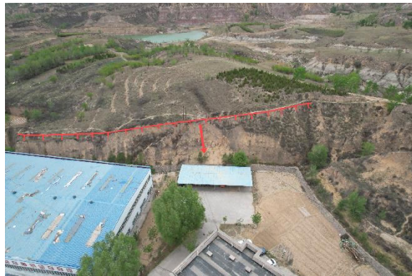
照片 4.1-6 崩塌隐患 BY05（镜向 320°）
