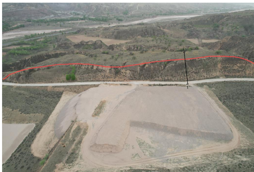
照片 4.2-11 不稳定斜坡 BW03 全貌（镜向 315°）
