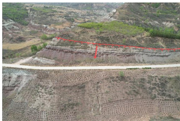
照片 4.1-4 崩塌隐患 BY03（镜向 225°）
