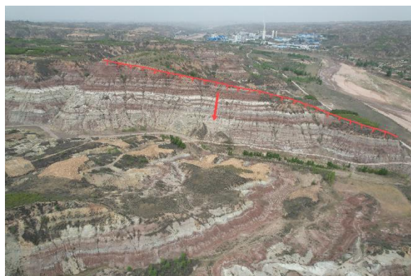
照片 4.1-3 崩塌隐患 BY02（镜向 315°）
