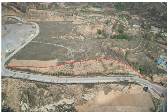
照片 4.1-9 不稳定斜坡 BW01（镜向 315°）
