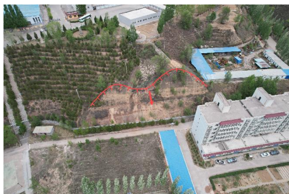
照片 4.1-7 崩塌隐患 BY06（镜向 50°）
