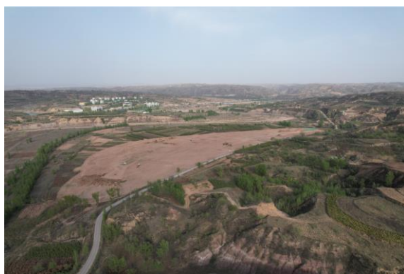
照片 2.2-3 正在平整的场地（镜向 50°）
