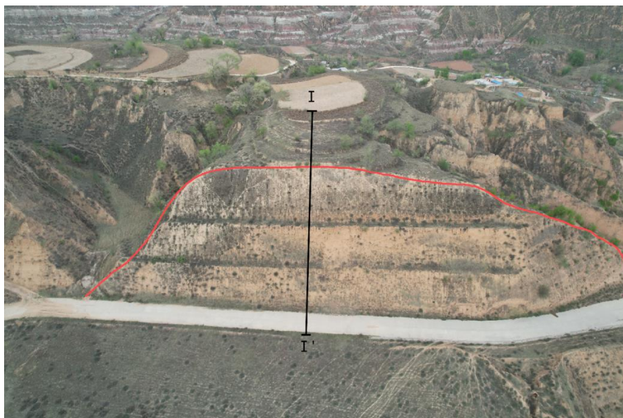
照片 4.2-10 不稳定斜坡 BW02 全貌（镜向 315°）
