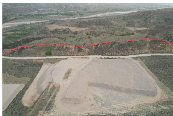
照片 4.1-11 不稳定斜坡 BW03（镜向 315°）
