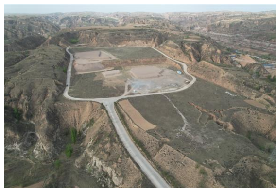
照片 2.2-4 已平整好场地（镜向 10°）
