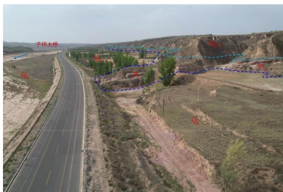
照片 3.3-1 评估区西北侧河道北岸地层 (镜向320°)
