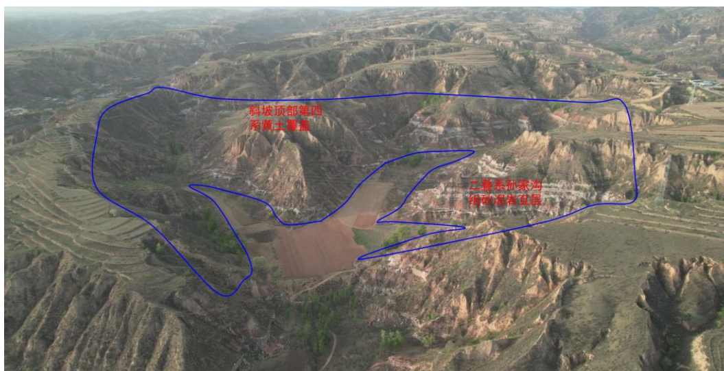
照片 5.1-4 II4 范围内斜坡地带（镜向 20°）
