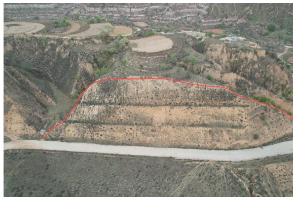
照片 4.1-10 不稳定斜坡 BW02（镜向 315°）
