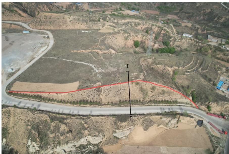
照片 4.2-9 不稳定斜坡 BW01 全貌（镜向 315°）
