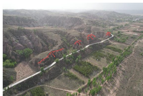
照片 4.1-8 崩塌隐患 BY07（镜向 300°）
