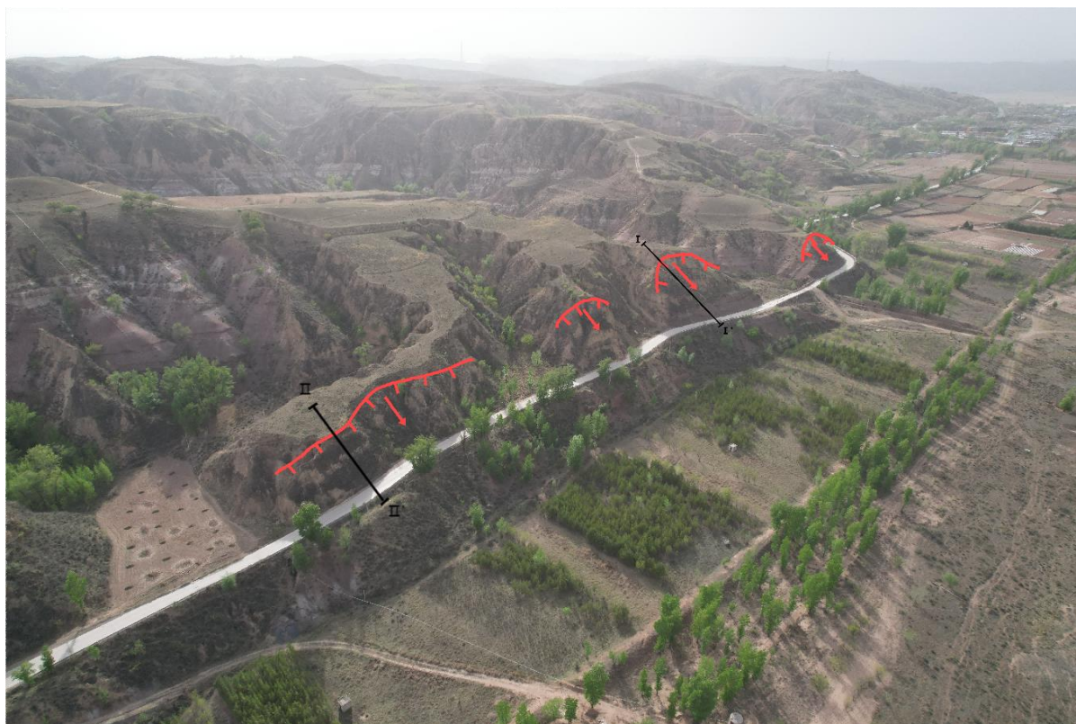
照片 4.2-8 崩塌隐患 BY07 全貌（镜向 300°）
