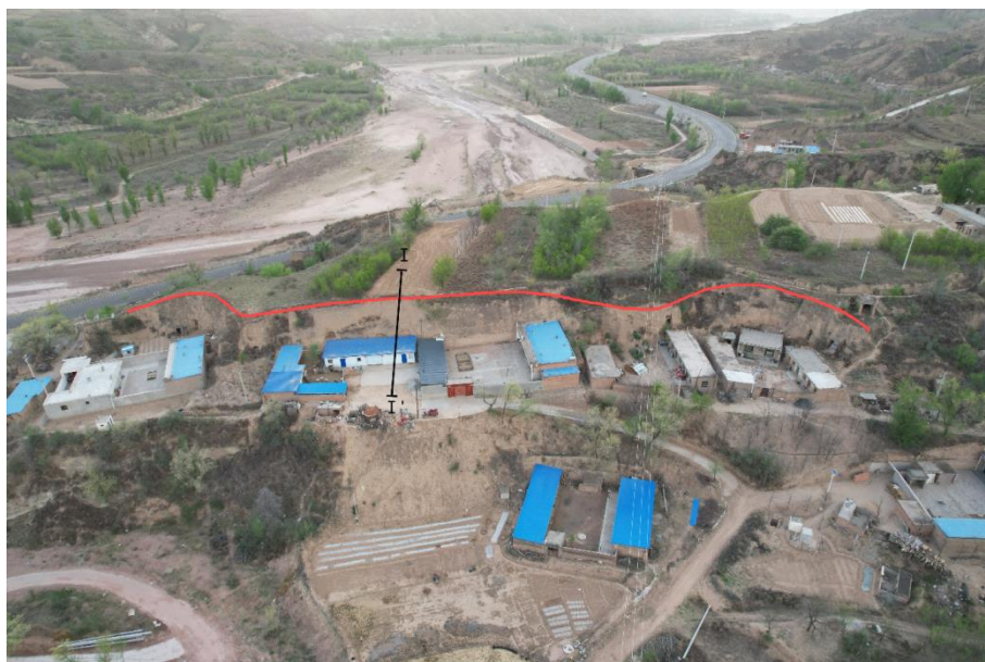
照片 4.2-12 不稳定斜坡 BW04 全貌（镜向 315°）
