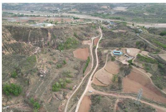
照片 3.1-2 杨家湾村西北侧沟道（镜向 210°）
