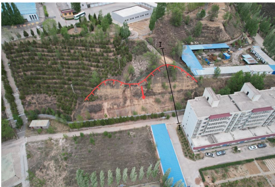
照片 4.2-7 崩塌隐患 BY06 全貌（镜向 50^{\circ} ）
