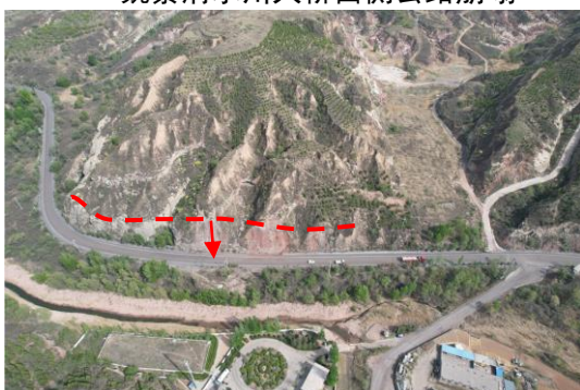
照片 4.1-21 崩塌 B21（镜向 140°） ——铺子坪公路拐弯处崩塌
