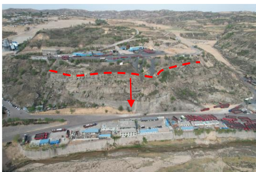
照片 4.1-13 崩塌 B13（镜向 35°） ——冯家塔煤矿东入口崩塌
