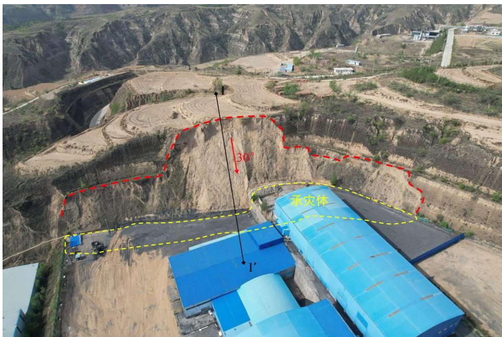
照片 4.2-30 滑坡 H01（镜向 210°）——宝恒洗选煤厂后滑坡
