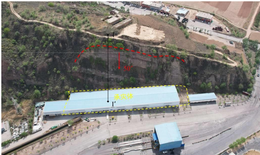
照片 4.2-12 崩塌 B12（镜向 200^\circ ）——新元洁能库房后崩塌
