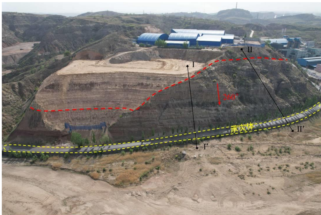
照片 4.2-6 崩塌 B06（镜向 110°）——鼎园洗选煤厂南侧魏哈路崩塌
