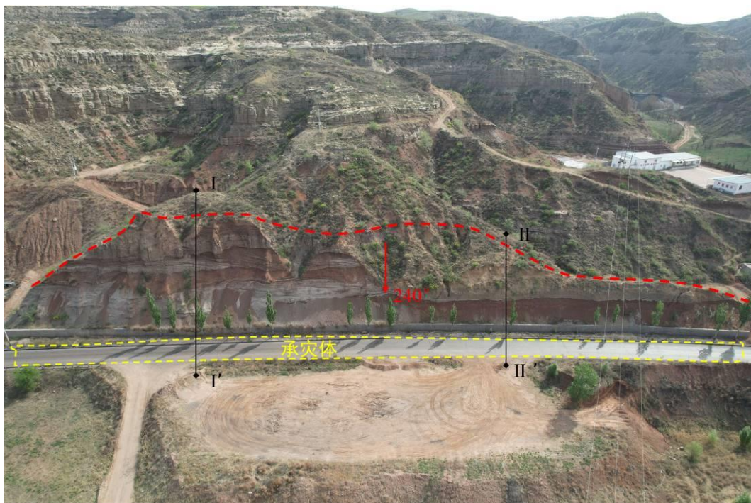
照片 4.2-3 崩塌 B03（镜向 50°）——国华石油南侧 200 m 处崩塌
