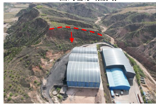
照片 4.1-10 崩塌 B10（镜向 230°） ——岐源洗煤厂道路崩塌
