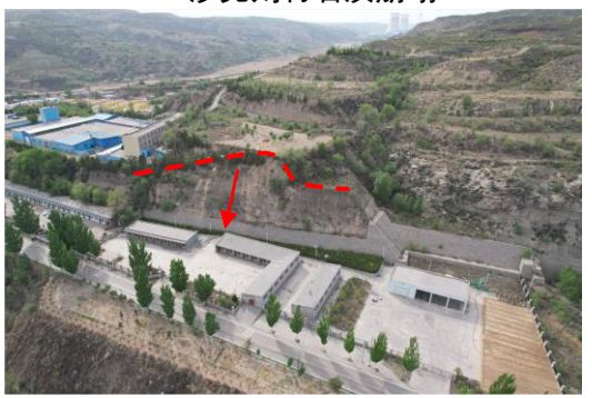
照片 4.1-29 滑坡隐患 HY01（镜向 300°） ——沙尧则道班房后滑坡隐患
