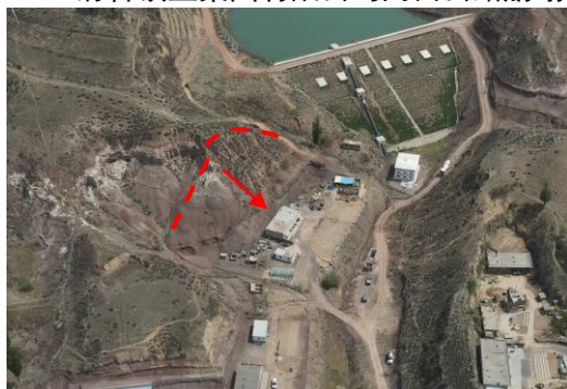
照片 4.1-18 崩塌 B18（镜向 30°） ——庙梁小长沟水库坝体西侧崩塌
