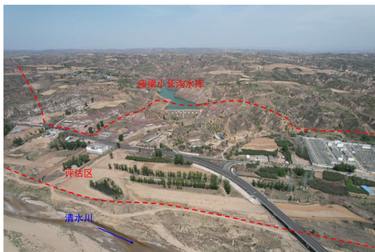
照片 3.8-10 庙梁小长沟水库（镜向 20°）
