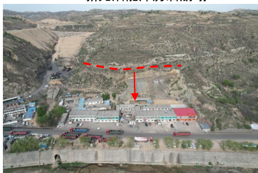
照片 4.1-14 崩塌 B14（镜向 30°） ——寨崖湾杨思虎家屋后崩塌
