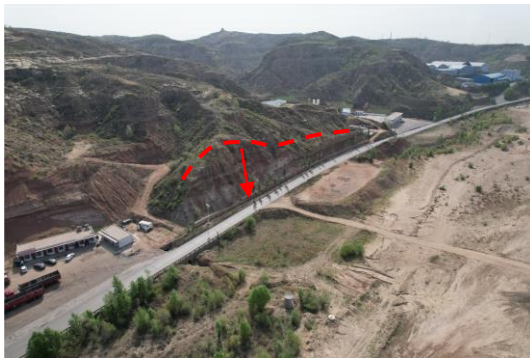
照片 4.1-3 崩塌 B03（镜向 140^{\circ} ） ——国华石油南侧 200 m 处崩塌
