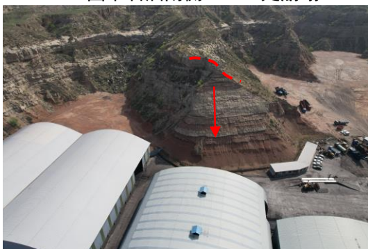
照片 4.1-5 崩塌 B05（镜向 85^{\circ} ） ——鼎园洗选煤厂东北侧崩塌
