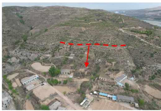
照片 4.1-26 崩塌 B26（镜向 70°） ——沙尧则村岩质崩塌 1
