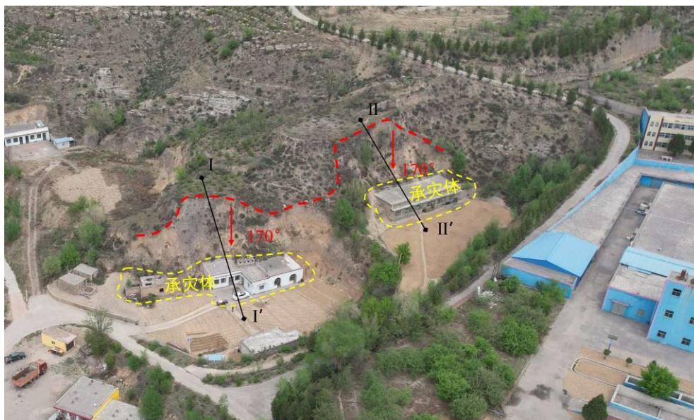
照片 4.2-28 崩塌 B28（镜向 10°）——沙尧则村土质崩塌
