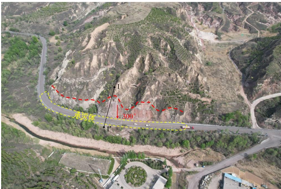
照片 4.2-21 崩塌 B21（镜向 140°）——铺子坪公路拐弯处崩塌
