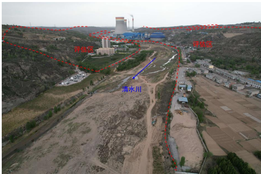
照片 3.1-1 评估区与清水川河相对位置航拍照片（镜向 320°）
