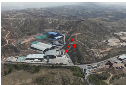
照片 4.1-9 崩塌 B09（镜向 100°） ——姬顺小屋后崩塌
