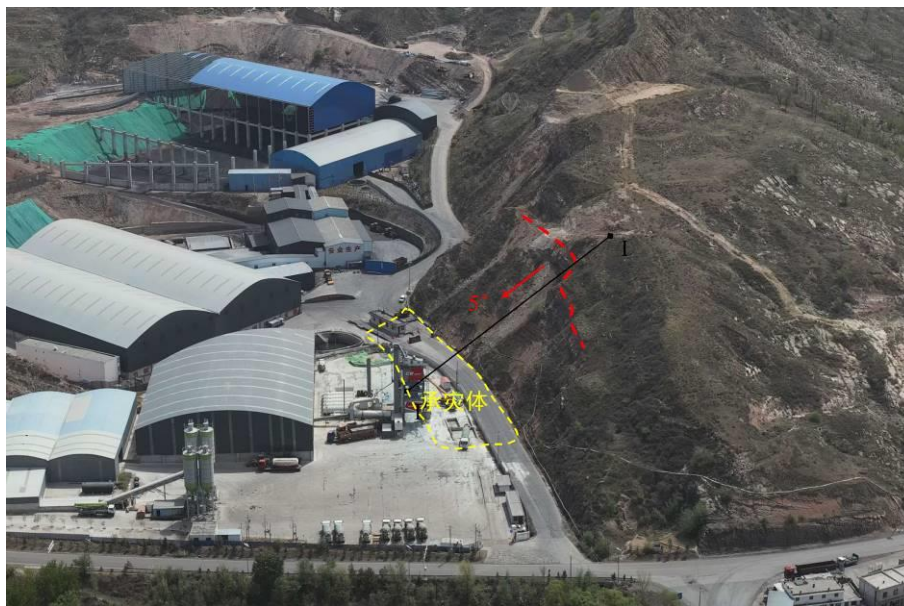
照片 4.2-9 崩塌 B09（镜向 100°）——姬顺小屋后崩塌
