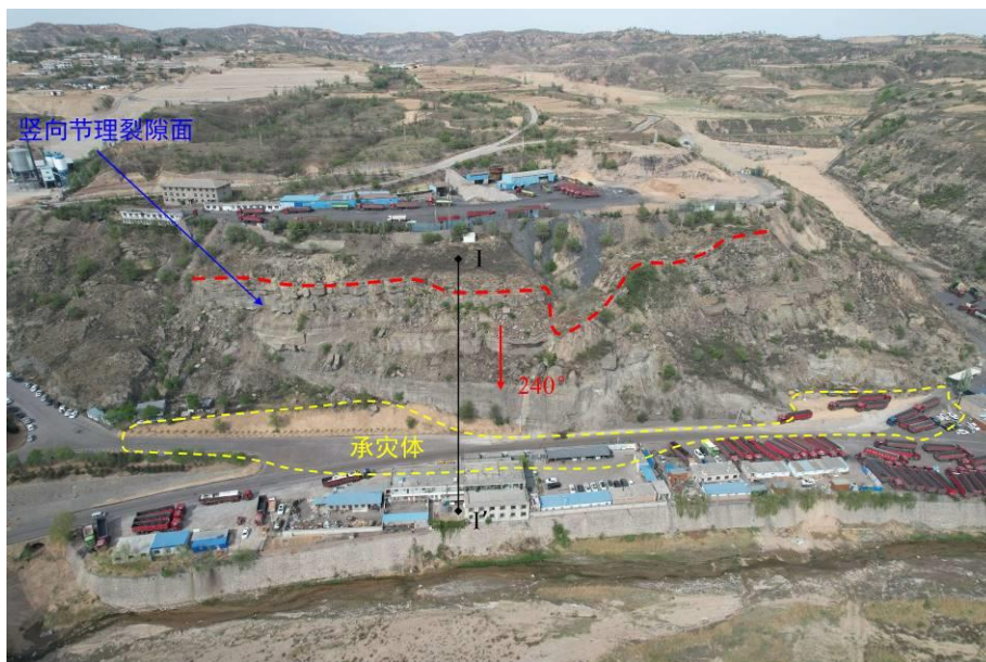
照片 4.2-13 崩塌 B13（镜向 35°）——冯家塔煤矿东入口崩塌
