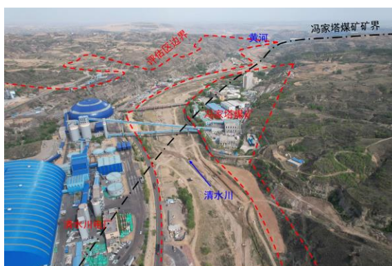
照片 3.8-1 冯家塔煤矿（镜向 130°）
