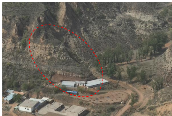
照片 3.8-9 建房孕育的崩塌隐患（镜向 190°）
