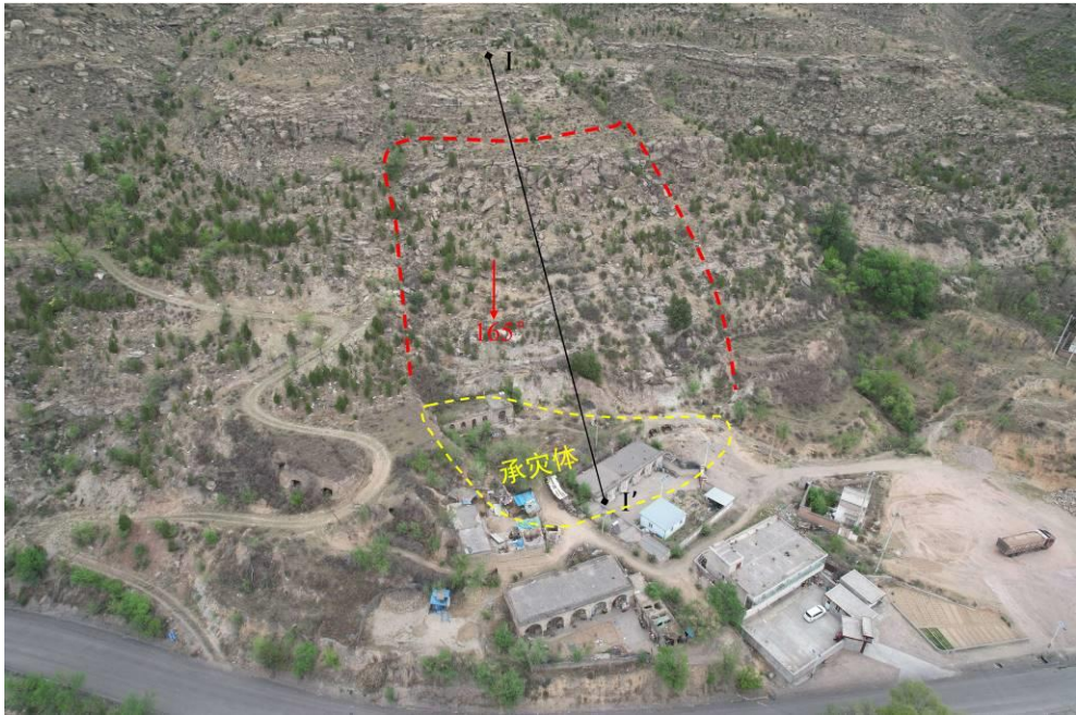
照片 4.2-25 崩塌 B25（镜向 10°）——柏树庄岩质崩塌
