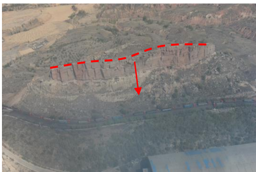
照片 4.1-7 崩塌 B07（镜向 330°） ——庄则村通村路崩塌
