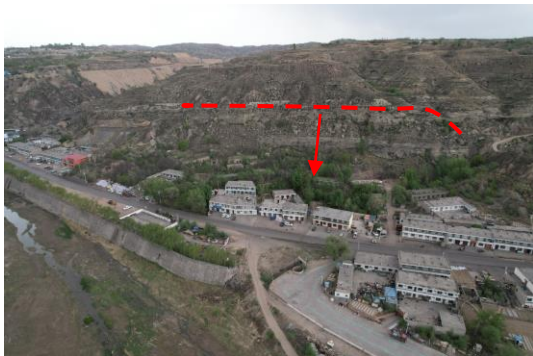
照片 4.1-23 崩塌 B23（镜向 20°） ——杨思虎家东南侧 150m 处崩塌
