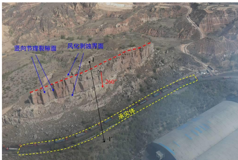
照片 4.2-7 崩塌 B07（镜向 330°）——庄则村通村路崩塌
