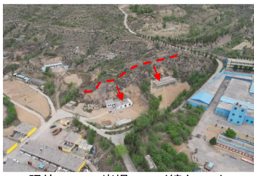
照片 4.1-28 崩塌 B28（镜向 10°） ——沙尧则村土质崩塌
