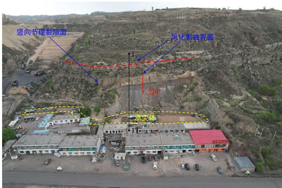
照片 4.2-14 崩塌 B14（镜向 30^{\circ} ）——寨崖湾杨思虎家屋后崩塌
