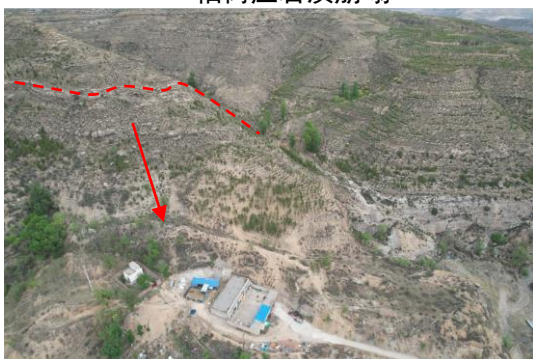
照片 4.1-27 崩塌 B27（镜向 30°） ——沙尧则村岩质崩塌 2
