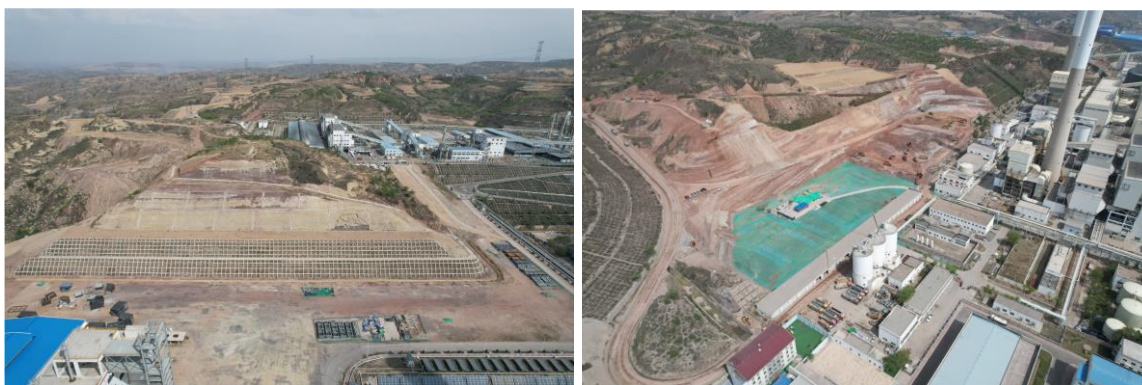
照片 2.2-7 新元洁能场地开挖及边坡防护（镜向 150°）照片 2.2-8 清水川电厂东北侧场地扩建（镜向 60°）
