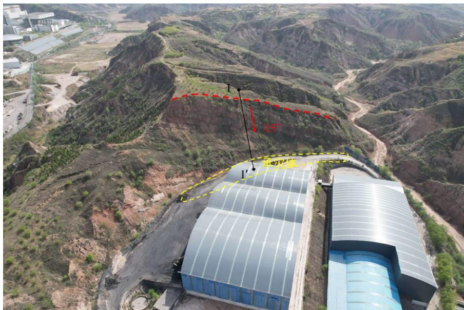
照片 4.2-10 崩塌 B10（镜向 230°）——岐源洗煤厂道路崩塌
