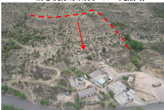
照片 4.1-25 崩塌 B25（镜向 10°） ——柏树庄岩质崩塌
