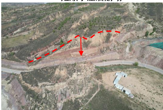
照片 4.1-11 崩塌 B11（镜向 50°） ——王家焉路边崩塌
