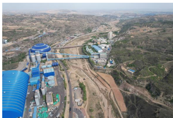
照片 2.2-2 冯家塔煤矿（镜向 100°）
