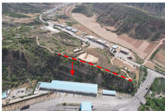
照片 4.1-12 崩塌 B12（镜向 200°） ——新元洁能库房后崩塌
