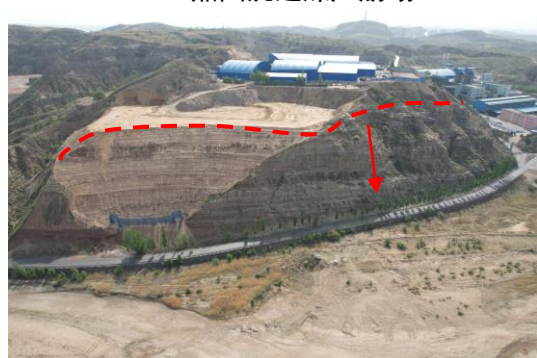
照片 4.1-6 崩塌 B06（镜向 110^{\circ} ） ——鼎园洗选煤厂南侧魏哈路崩塌
