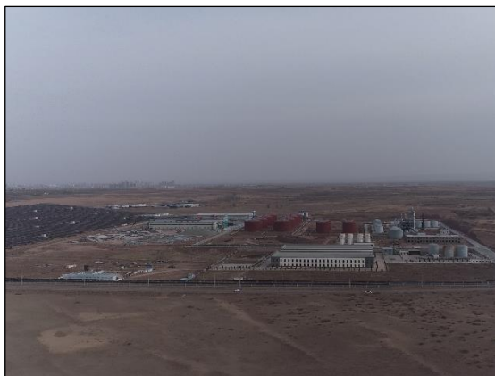
照片 3-20 工厂建设 镜向 210°
