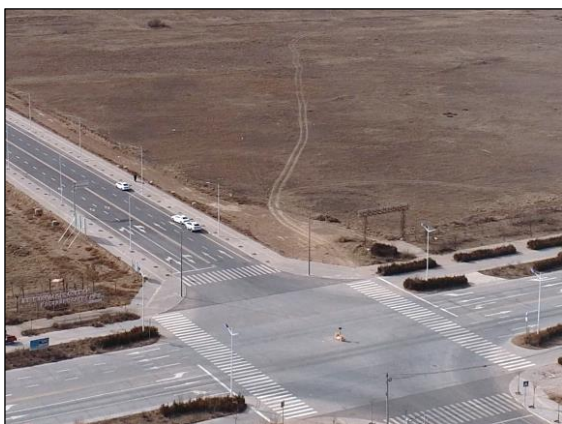
照片 2-1 园区内道路 航拍 镜向 300°
