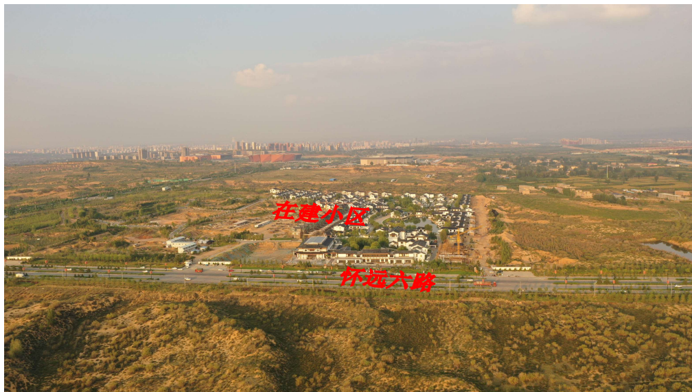
照片 4-2 在建小区 镜向 90°
