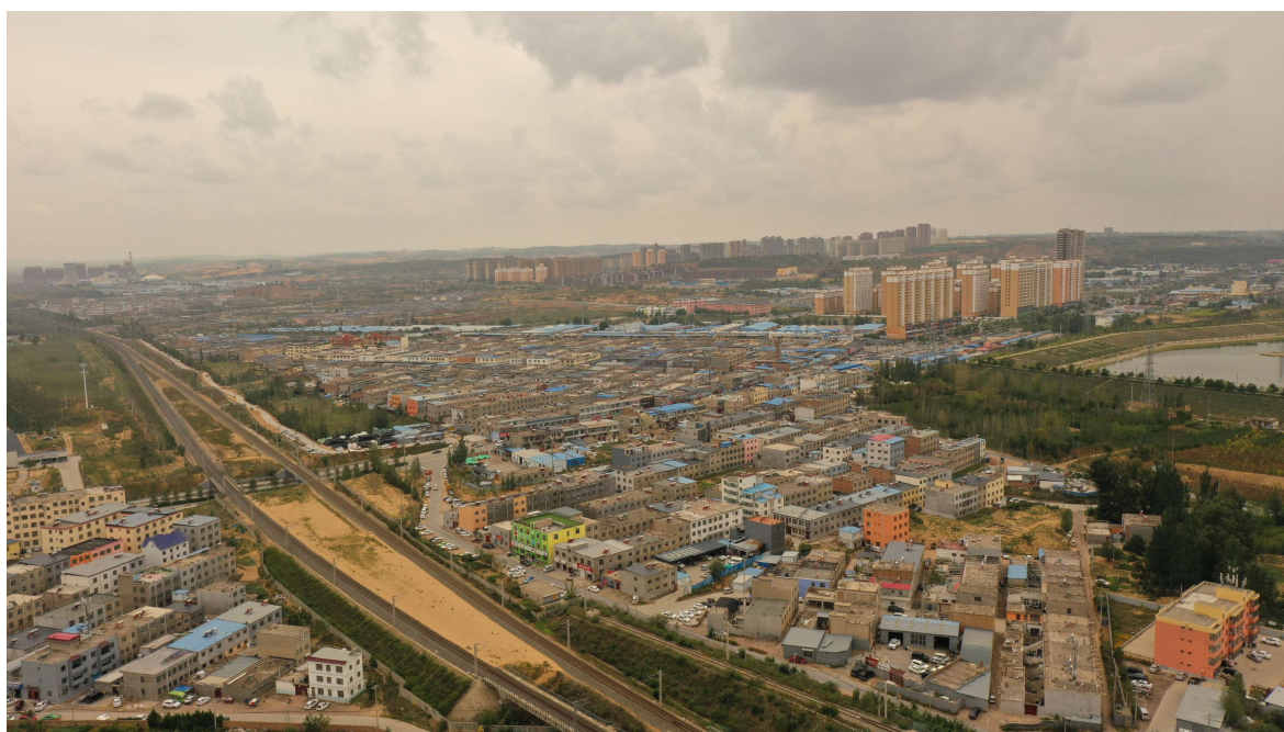
照片 2-6 城镇及交通等基础设施 镜向 180°
