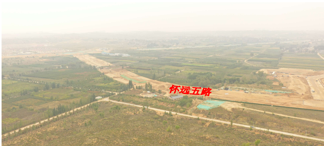
照片 4-3 在建道路 镜向 95°
