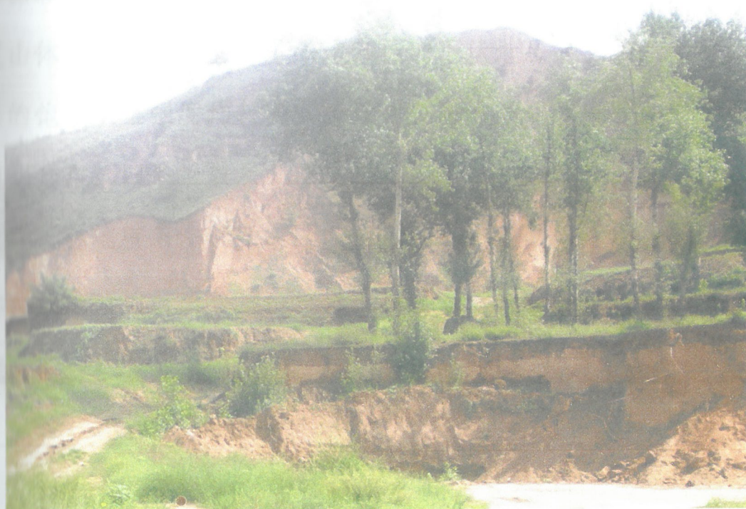
照片 3 评估区居民取土形成的高陡人工边坡
