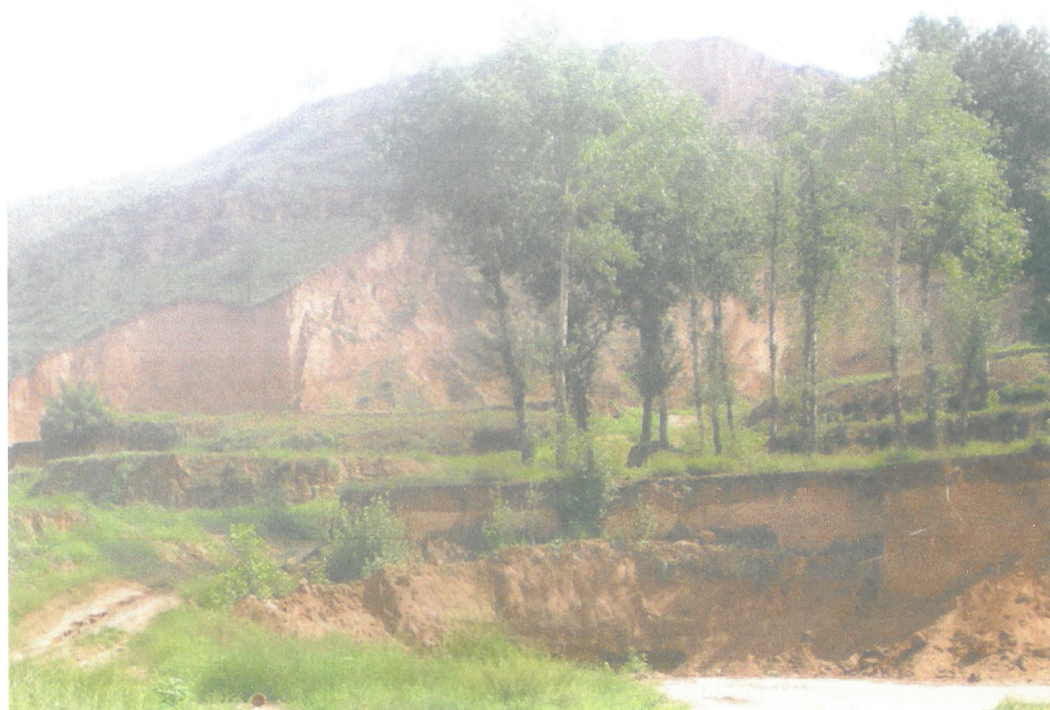
照片 4 人工开挖坡脚形成的高陡边坡
