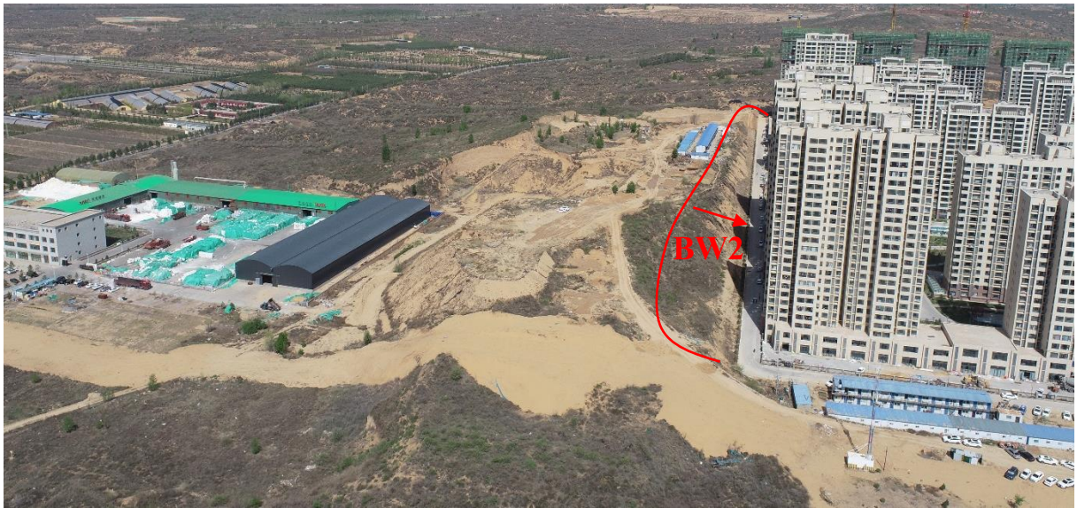
照片 4-6 不稳定斜坡 BW2 全貌（镜向 320°）
