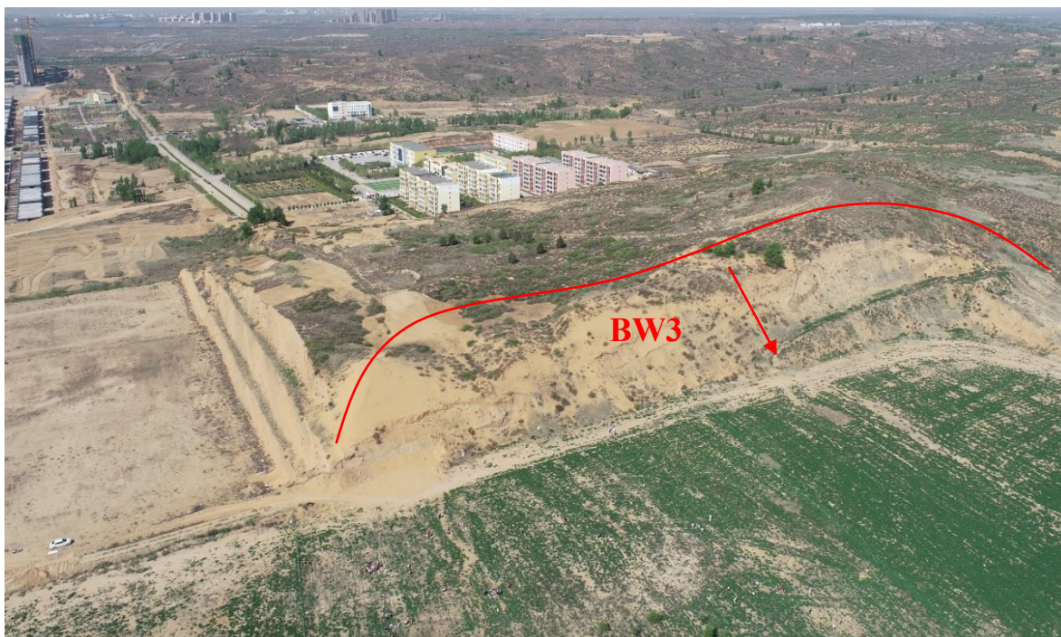
照片 4-7 不稳定斜坡 BW3 全貌（镜向 263°）
