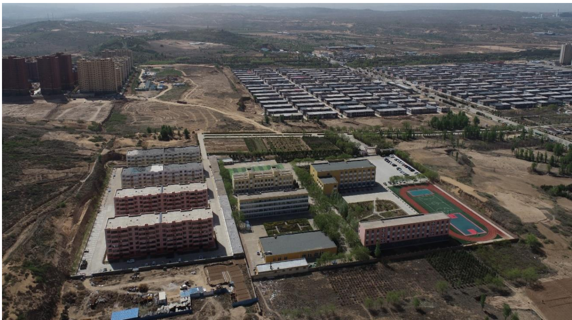
照片 3-9 评估区北区已建建筑（镜像 325°）
