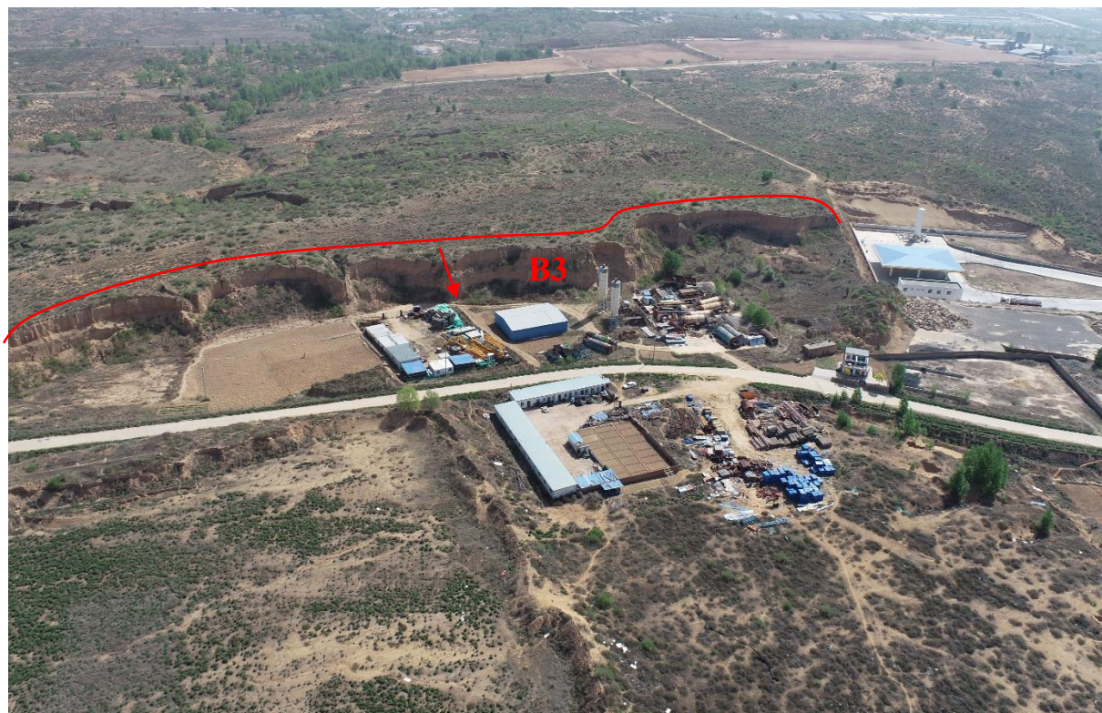
照片 4-3 B3 崩塌全貌（镜向 81°）
