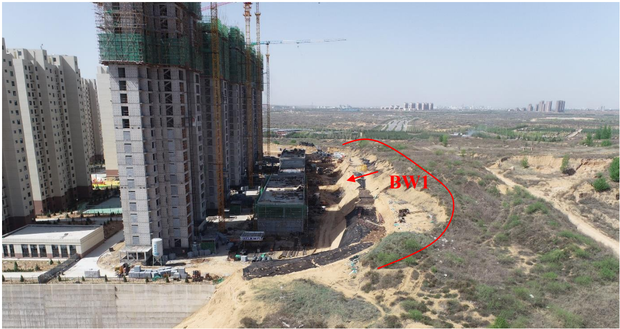
照片 4-5 不稳定斜坡 BW1 全貌（镜向 240°）
