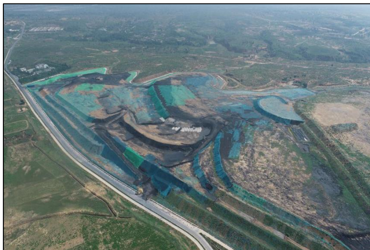
照片 5-7 工业废渣厂建设情况（镜向 133°）
