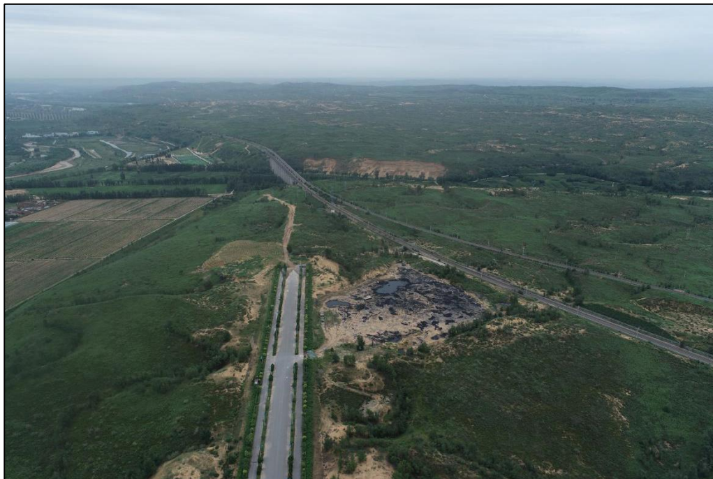
照片 33 新开沟北岸沟口地形地貌（航拍）
