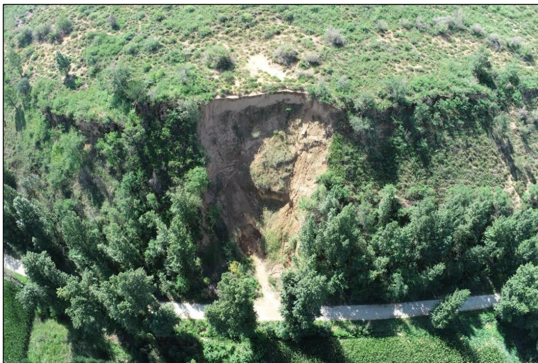
照片 3-3 坡体局部变形破坏区 1 航拍图（镜向 117°）
