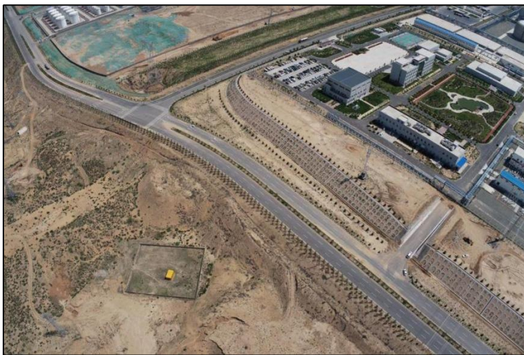
照片 3-15 榆横工业园区南区工程建设改变地貌（镜向 70°）
