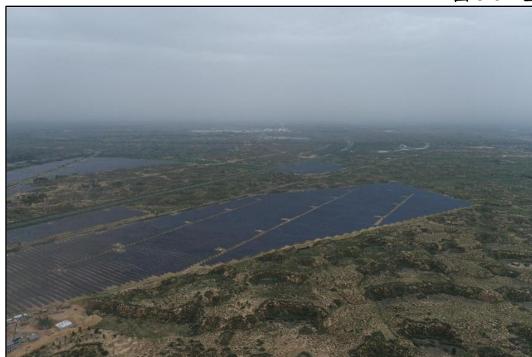
照片 5-8 光伏场地建设情况（镜向 0°）
