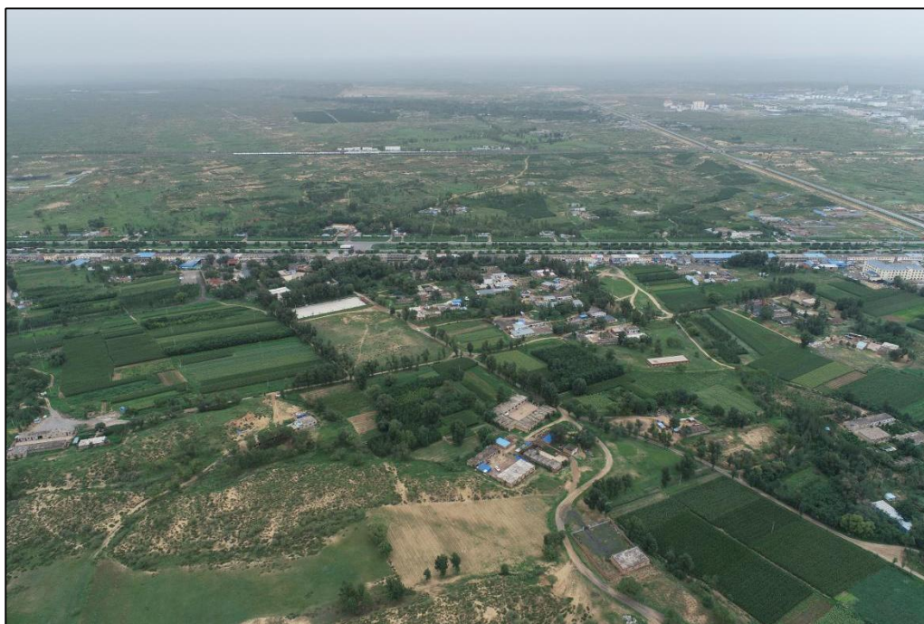
照片 4 评估区北部马扎梁村周边地形地貌 2（航拍）
