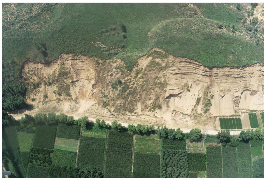
照片 3-7 不稳定斜坡 XP3 右侧（镜向 192°）
