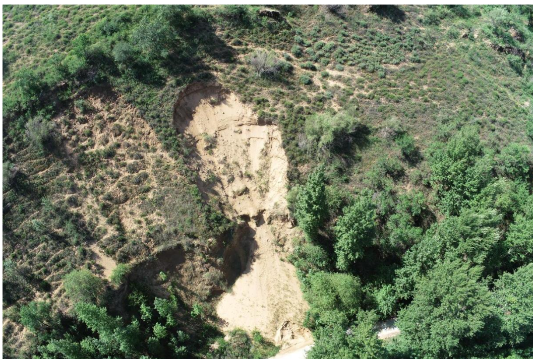
照片 3-4 坡体局部变形破坏区 2 航拍图（镜向 153°）
