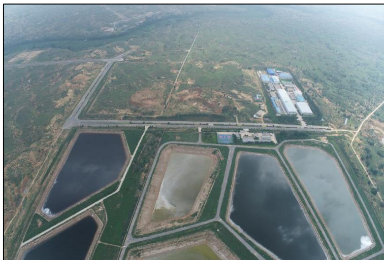
照片 5-6 污水处理厂建设情况（镜向 90°）
