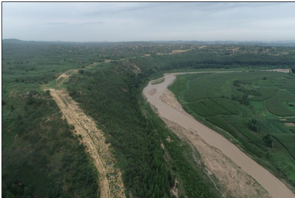
照片 29 评估区东南部榆溪河西岸现状 1（航拍）
