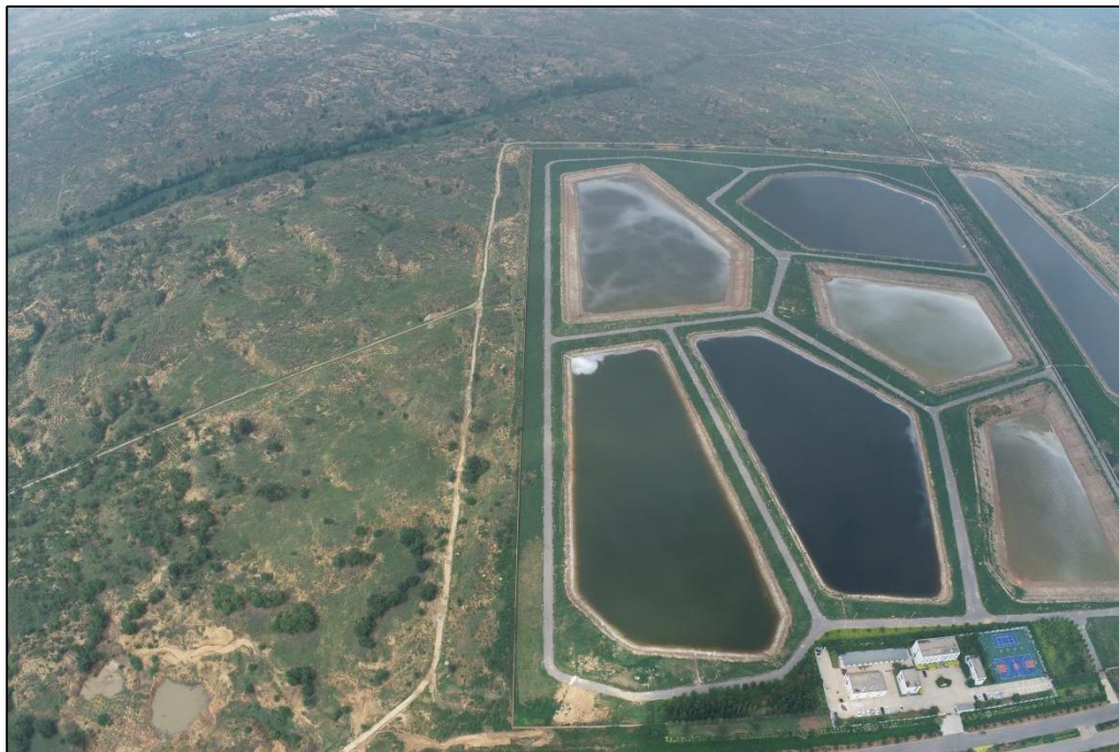
照片 15 评估区南部污水处理厂周边地形地貌 1（航拍）
