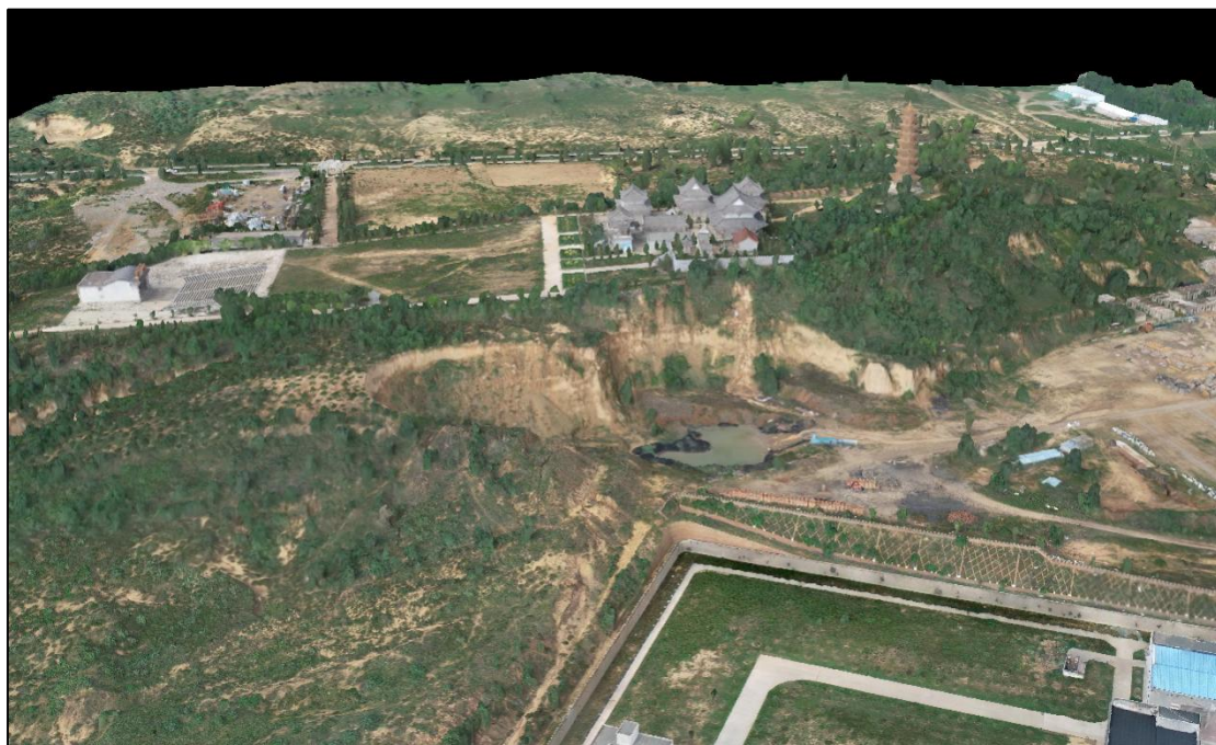
图 7 聚云寺崩塌（B2）三维模型正视图
