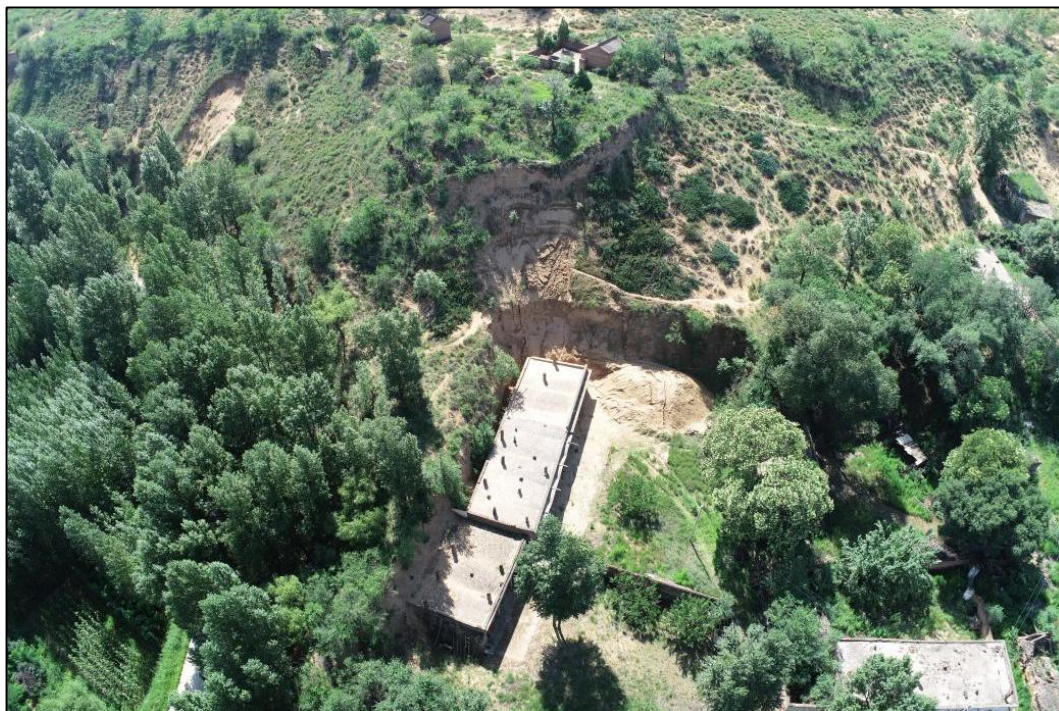
照片 3-5 坡体局部变形破坏区 3 航拍图（镜向 133^\circ ）
