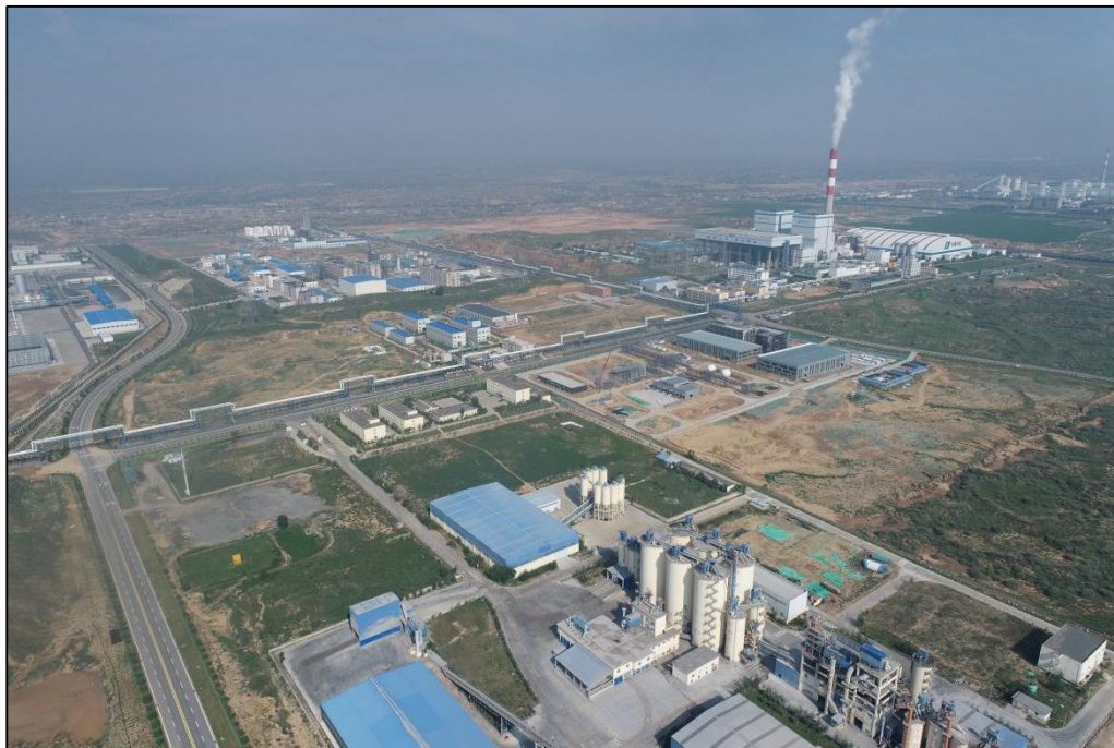
照片 21 评估区西部中国华电航拍图（航拍）
