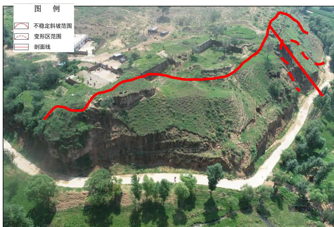
照片 3-8 方河沟不稳定斜坡（XP4）全貌图（镜向 202°）
