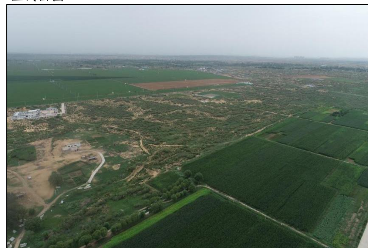
照片 5-9 评估区西北部建设情况（镜向 331°）
