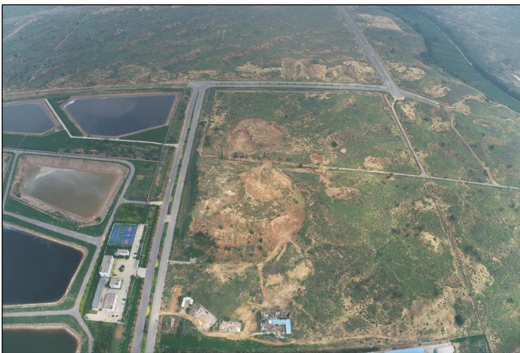
照片 14 评估区南部污水处理厂周边地形地貌 2（航拍）
