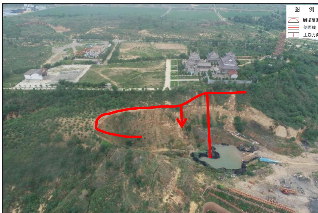
照片 3-2 聚云寺东侧崩塌（B2）全貌图（航镜像 241°）
