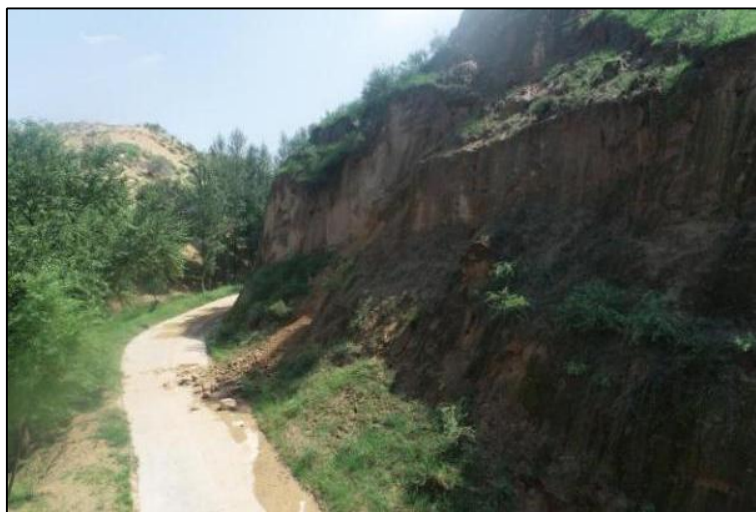
照片 3-13 道路工程建设照片开挖坡脚（镜向 53°）
