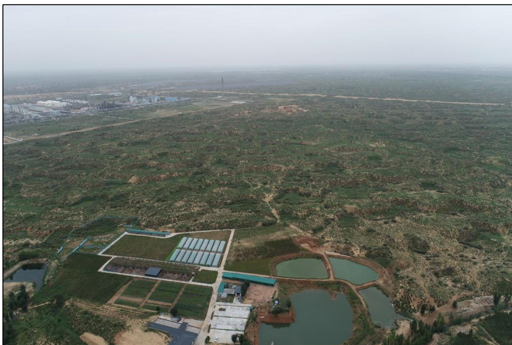
照片 2 评估区北部马扎梁村周边地形地貌（航拍）
