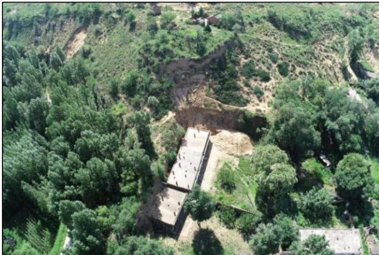
照片 3-14 新开沟右岸当地居民挖坡建房（镜向 133°）
