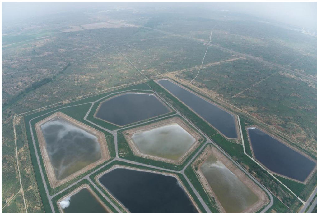
照片 13 评估区南部污水处理厂航拍图（航拍）
